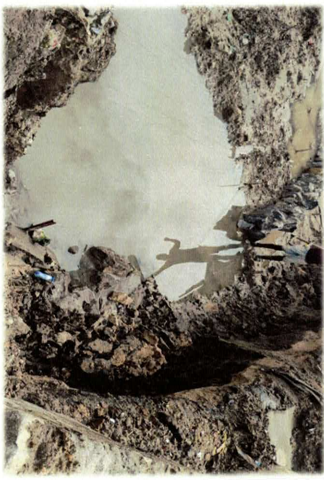
Foto n. 12 ESCAVAÇÃO MANUAL DE VALA
