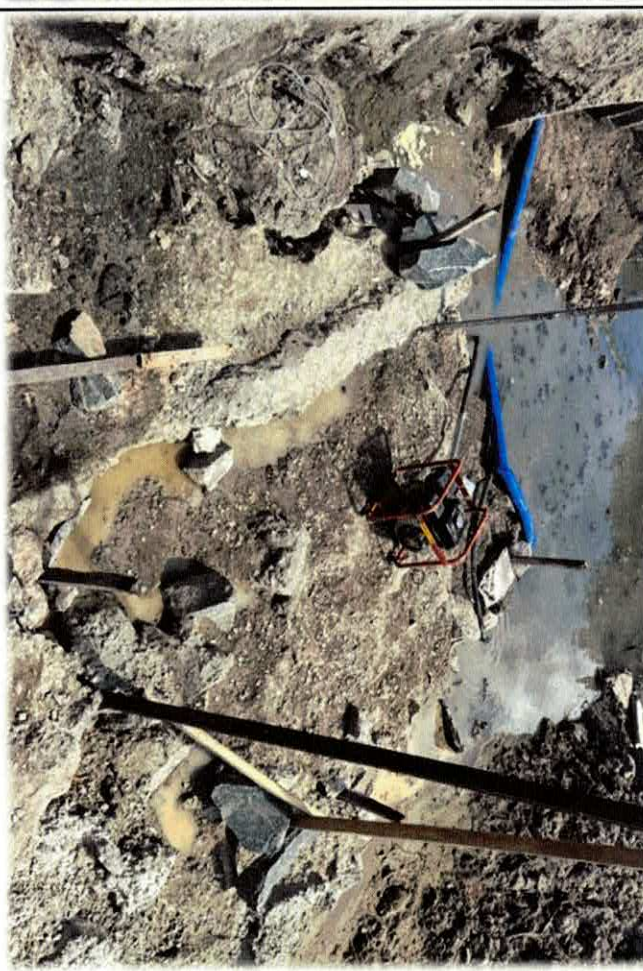
Foto n. 10 ESGOTAMENTO COM BOMBA SUBMERSIVEL
