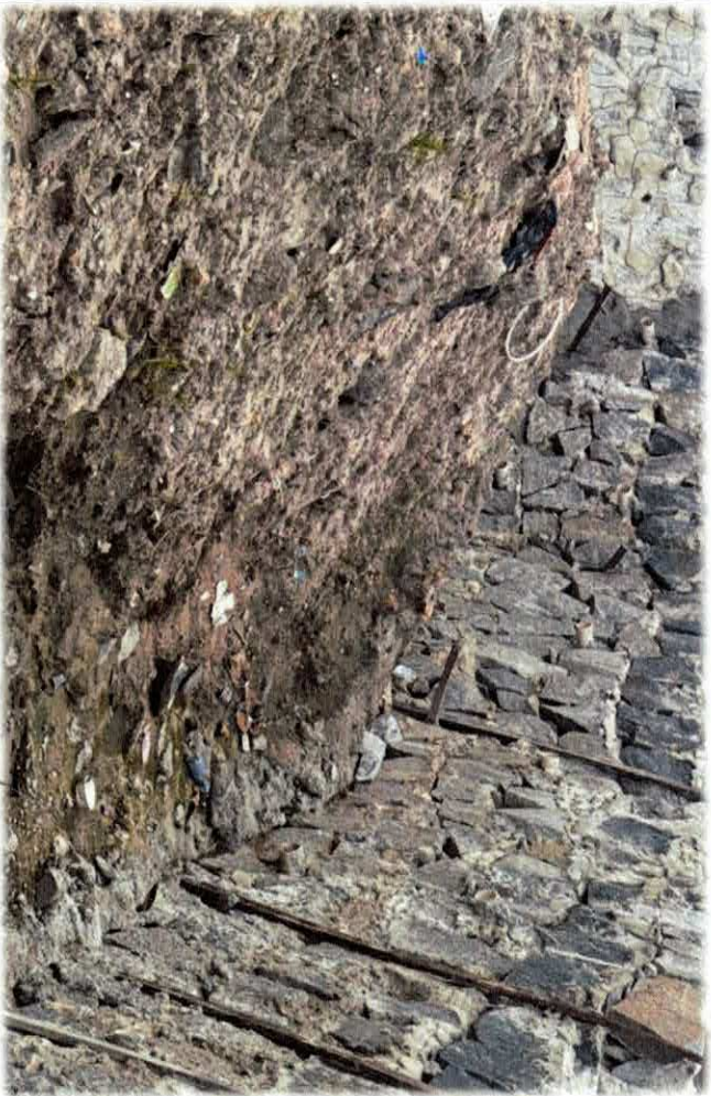
Foto n. 07 EXECUÇÃO DE DIQUE TIPO ENSECADEIRA
