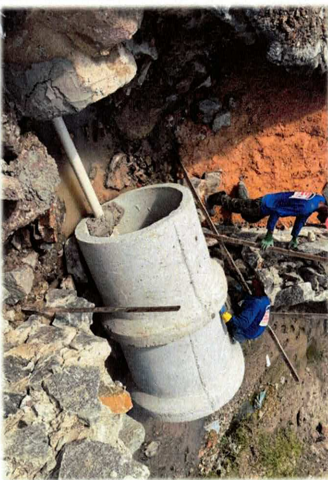
Foto n. 30 ASSENTAMENTO DE TUBO DE CONCRETO PARA REDES COLETORAS DE ÁGUAS PLUVIAIS, DIÂMETRO DE 1000 MM
