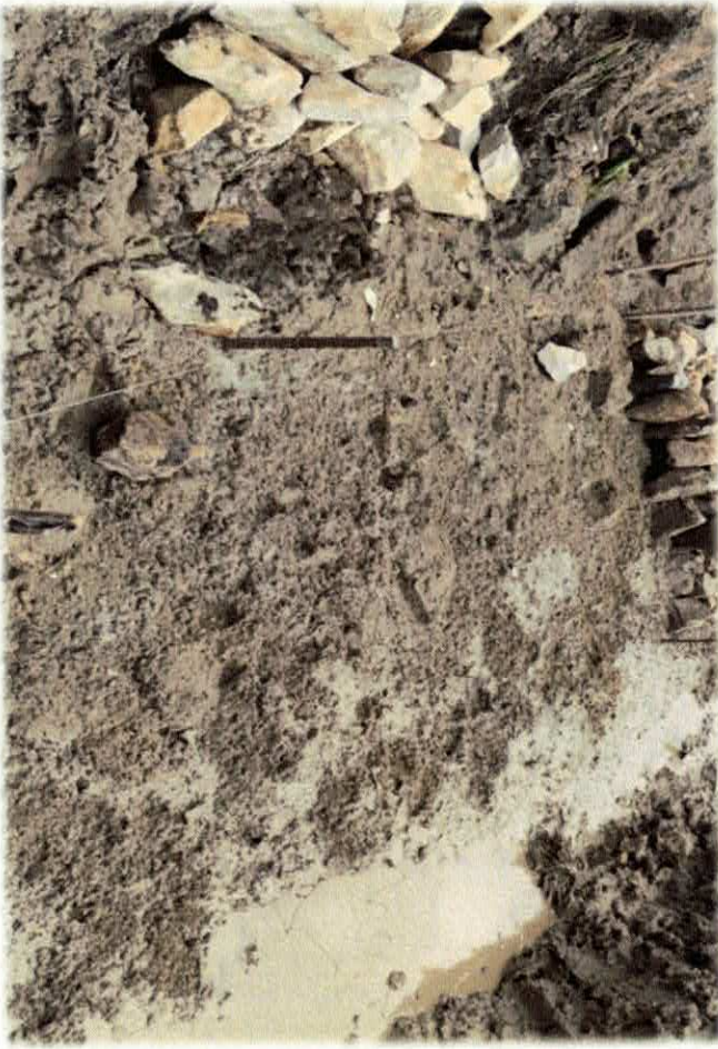
Foto n. 16 REGULARIZAÇÃO E COMPACTAÇÃO DE TERRENO
