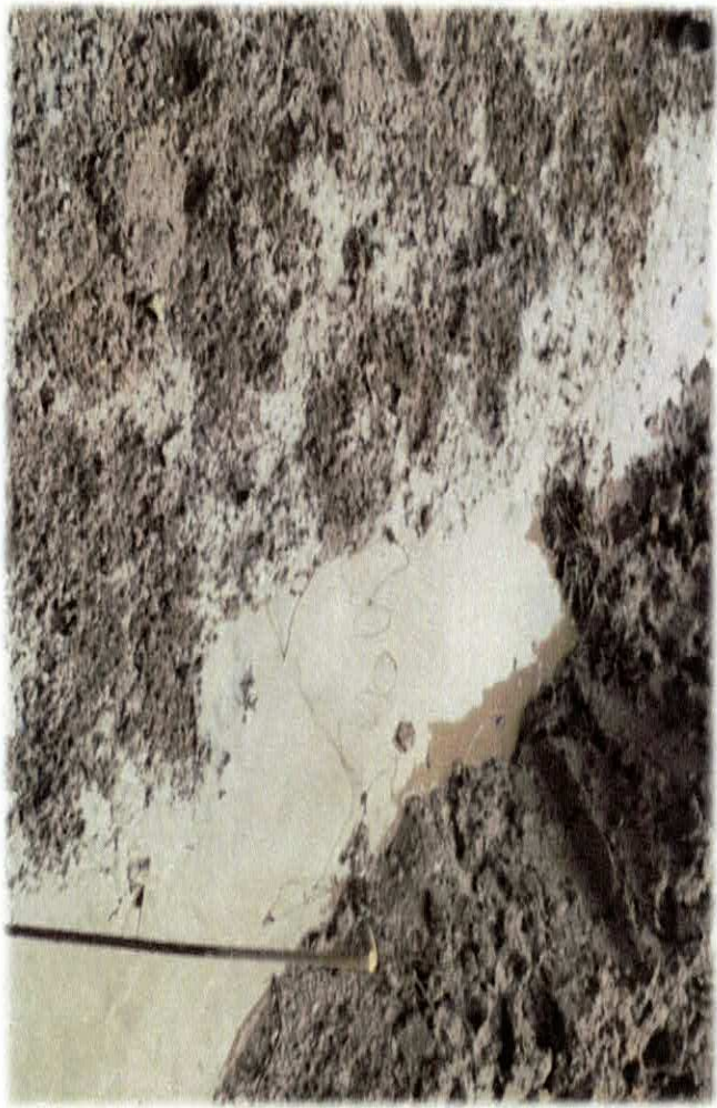
Foto n. 15 REGULARIZAÇÃO E COMPACTAÇÃO DE TERRENO
