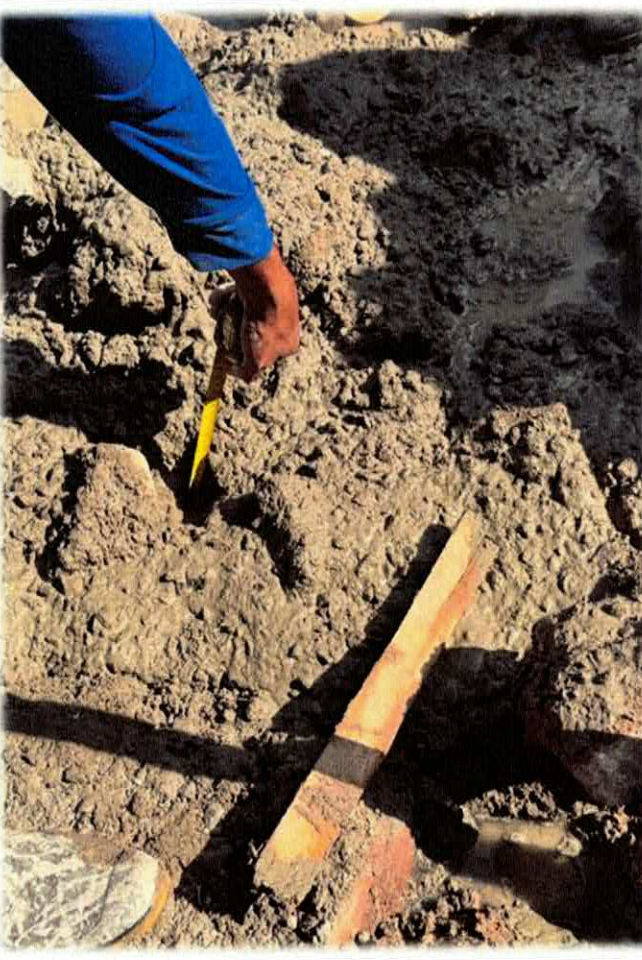
Foto n. 18 CONCRETO MAGRO PARA LASTRO
