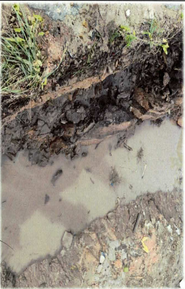
Foto n. 11 ESCAVAÇÃO MANUAL DE VALA
