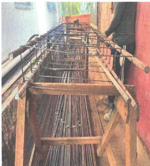
FOTO 05: ARMAÇÃO DE PILAR OU VIGA DE ESTRUTURA CONVENCIONAL DE CONCRETO ARMADO UTILIZANDO AÇO CA-50 DE 12,5 MM.
