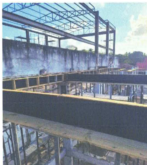
FOTO 10: FABRICAÇÃO DE FÔRMA PARA VIGAS, EM CHAPA DE MADEIRA COMPENSADA RESINADA, E = 17 MM.
