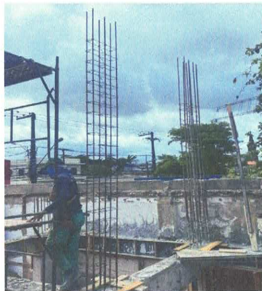
FOTO 06: ARMAÇÃO DE PILAR OU VIGA DE ESTRUTURA CONVENCIONAL DE CONCRETO ARMADO UTILIZANDO AÇO CA-50 DE 16,0 MM.
