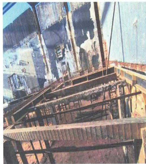
FOTO 16: ARMAÇÃO DE LAJE DE ESTRUTURA CONVENCIONAL DE CONCRETO ARMADO UTILIZANDO AÇO CA-50 DE 10,0 MM - MONTAGEM.
