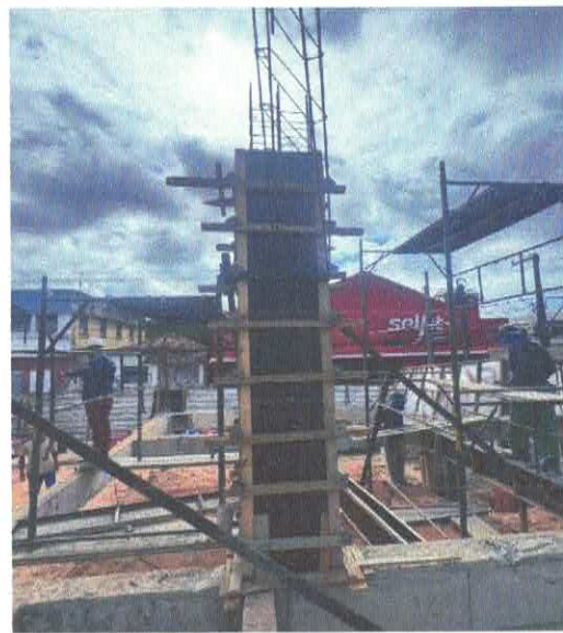
FOTO 04: FABRICAÇÃO DE FÔRMA PARA PILARES E ESTRUTURAS SIMILARES, EM CHAPA DE MADEIRA COMPENSADA RESINADA.
