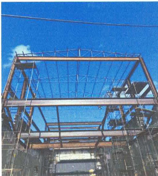
FOTO 21: ESTRUTURA TRELIÇADA DE COBERTURA, TIPO FINK, COM LIGAÇÕES SOLDADAS, INCLUSOS PERFIS METÁLICOS, CHAPAS METÁLICAS, MÃO DE OBRA E TRANSPORTE COM GUINDASTE.
