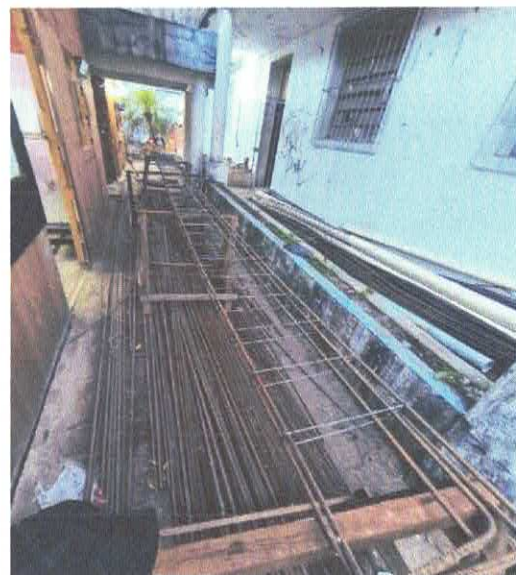
FOTO 08: ARMAÇÃO DE PILAR OU VIGA DE ESTRUTURA CONVENCIONAL DE CONCRETO ARMADO UTILIZANDO AÇO CA-60 DE 5,0 MM.
