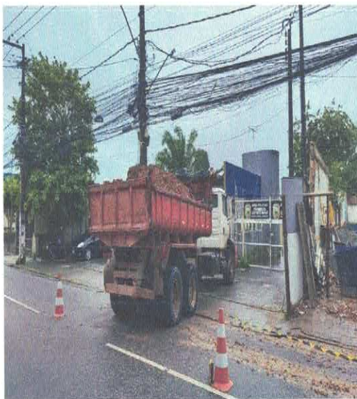
FOTO 01: CARGA, MANOBRA E DESCARGA DE ENTULHO EM CAMINHÃO BASCULANTE 10 M 3
