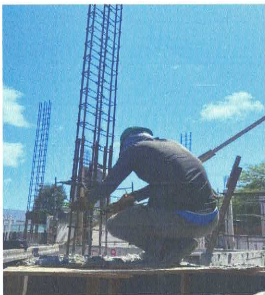
FOTO 13: ARMAÇÃO DE PILAR OU VIGA DE ESTRUTURA CONVENCIONAL DE CONCRETO ARMADO UTILIZANDO AÇO CA-50 DE 16,0 MM.
