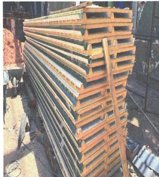
FOTO 24: TELHA METÁLICA SANDUICHE TRAPEZOIDAL 2 FACES TR40.
