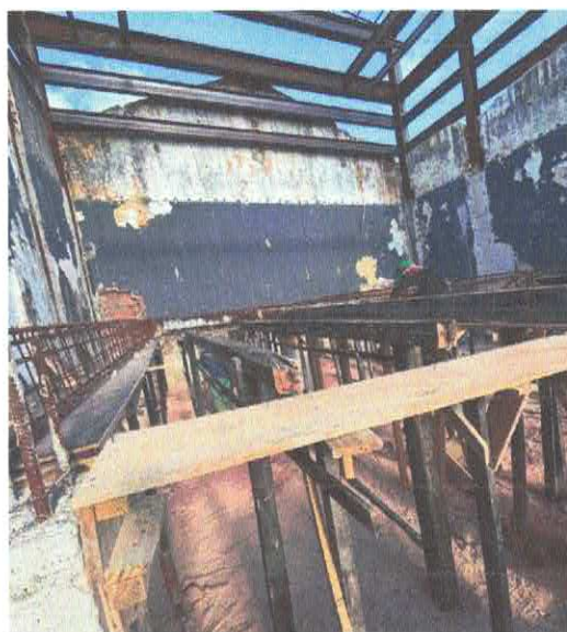
FOTO 19: ARMAÇÃO DE LAJE DE ESTRUTURA CONVENCIONAL DE CONCRETO ARMADO UTILIZANDO AÇO CA-50 DE 8,0 MM.
