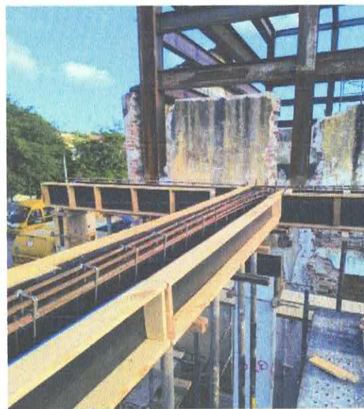
FOTO 12: ARMAÇÃO DE PILAR OU VIGA DE ESTRUTURA CONVENCIONAL DE CONCRETO ARMADO UTILIZANDO AÇO CA-50 DE 10,0 MM.
