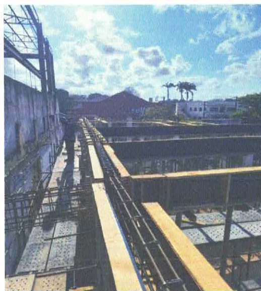
FOTO 15: ARMAÇÃO DE PILAR OU VIGA DE ESTRUTURA CONVENCIONAL DE CONCRETO ARMADO UTILIZANDO AÇO CA-50 DE 12,5 MM.
