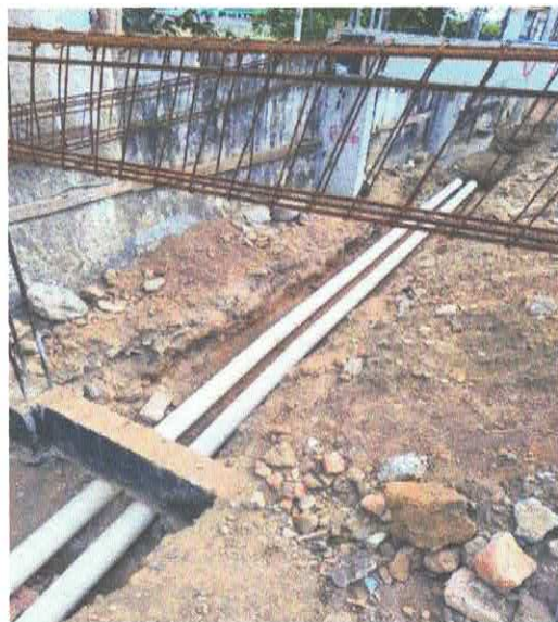
FOTO 22: TUBO PVC, SÉRIE R, ÁGUA PLUVIAL, DN 150 MM, FORNECIDO E INSTALADO EM CONDUTORES VERTICAIS DE ÁGUAS PLUVIAIS.
