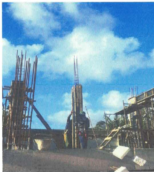
FOTO 14: ARMAÇÃO DE PILAR OU VIGA DE ESTRUTURA CONVENCIONAL DE CONCRETO ARMADO UTILIZANDO AÇO CA-60 DE 5,0 MM.
