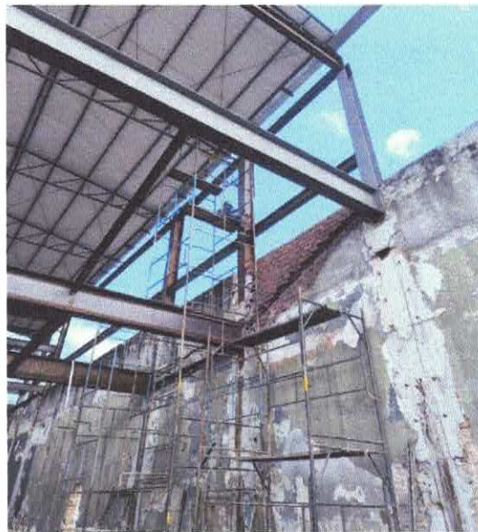
FOTO 18: LOCACAO DE ANDAIME METALICO TIPO FACHADEIRO, LARGURA DE 1,20 M X ALTURA DE 2,0 M POR PAINEL, INCLUINDO DIAGONAIS EM X, BARRAS DE LIGACAO.
