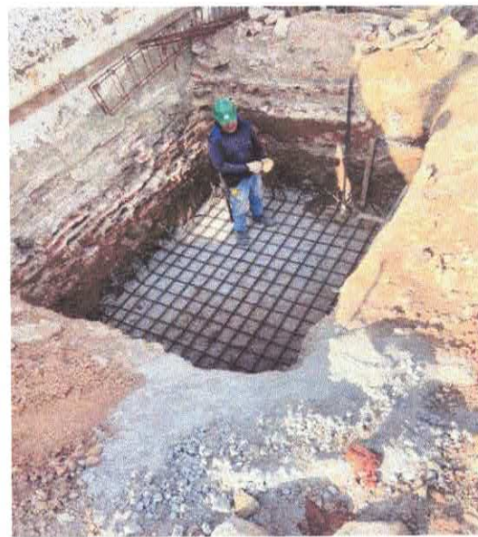
FOTO 08: ARMAÇÃO DE BLOCO, VIGA BALDRAME OU SAPATA UTILIZANDO AÇO CA-50 DE 16 MM.
