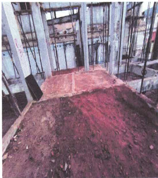
FOTO 02: ATERRO MECANIZADO DE VALA COM RETROESCAVADEIRA.
