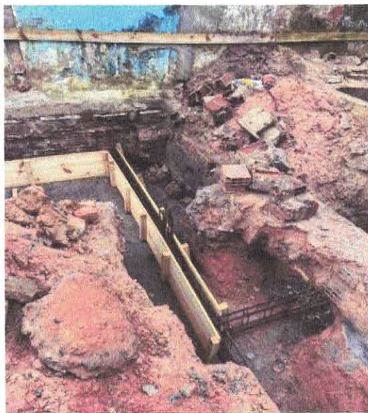
FOTO 06: ARMAÇÃO DE BLOCO, VIGA BALDRAME OU SAPATA UTILIZANDO AÇO CA-50 DE 10 MM.
