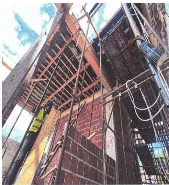
FOTO 14: COMP. 115 - Escoramento metálico para lajes e vigas, c/ escoras tubulares tipo "b" ( h=3,30 a 4,50 m).
