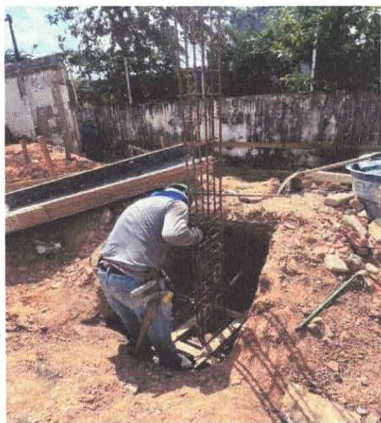
FOTO 09: ARMAÇÃO DE PILAR OU VIGA DE ESTRUTURA CONVENCIONAL DE CONCRETO ARMADO UTILIZANDO AÇO CA-50 DE 20,0 MM.
