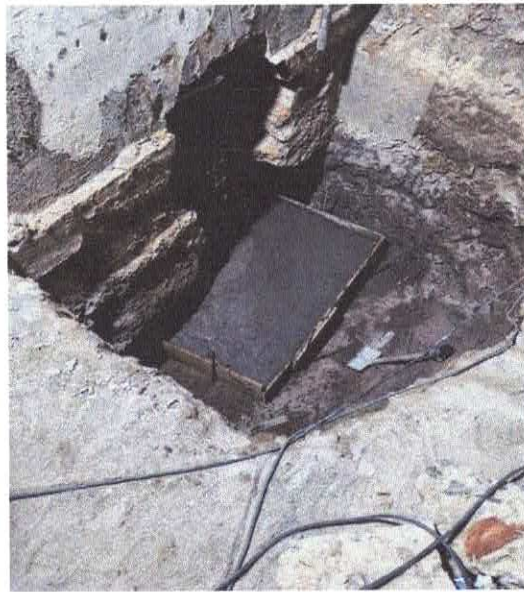
FOTO 04: FABRICAÇÃO, MONTAGEM E DESMONTAGEM DE FÔRMA PARA SAPATA, EM CHAPA DE MADEIRA COMPENSADA RESINADA, E=17 MM.
