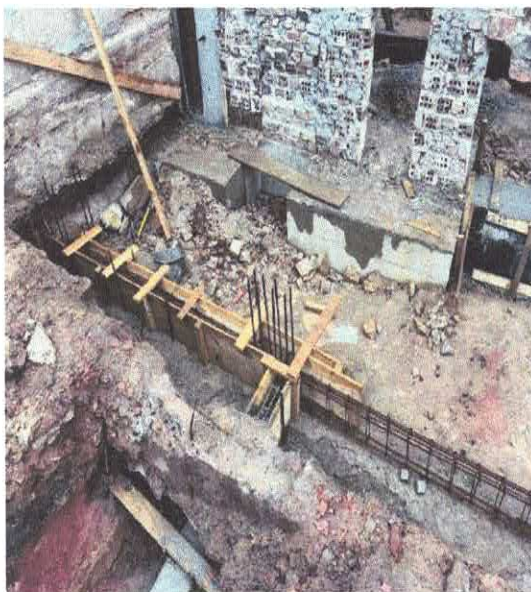
FOTO 05: ARMAÇÃO DE BLOCO, VIGA BALDRAME OU SAPATA UTILIZANDO AÇO CA-50 DE 8 MM.
