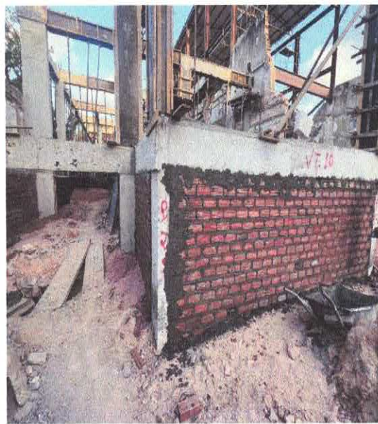
FOTO 16: Alvenaria de vedação de blocos cerâmicos furados na horizontal de 9 \times 19 \times 29 cm (espessura 9 cm) e argamassa de assentamento com preparo em betoneira.
