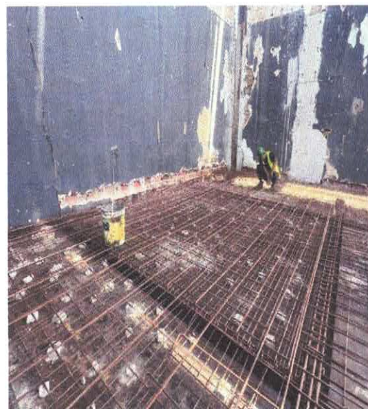
FOTO 11: ARMAÇÃO DE LAJE DE ESTRUTURA CONVENCIONAL DE CONCRETO ARMADO UTILIZANDO AÇO CA-50 DE 6,3 MM.
