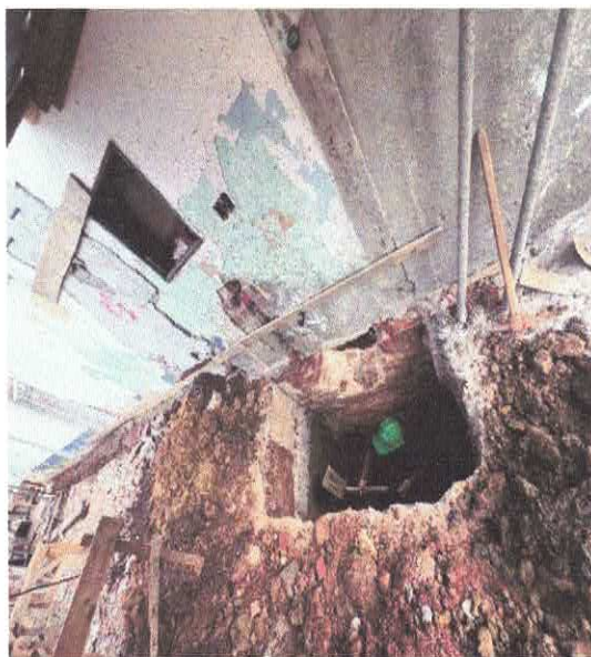
FOTO 01: ESCAVAÇÃO MANUAL PARA BLOCO DE COROAMENTO OU SAPATA.
