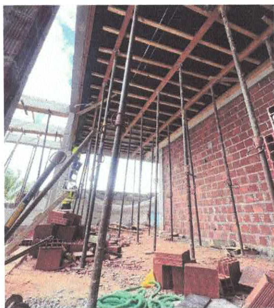
FOTO 15: COMP. 115 - Escoramento metálico para lajes e vigas, c/ escoras tubulares tipo "b" ( h=3,30 a 4,50 m), com montagem e desmontagem.
