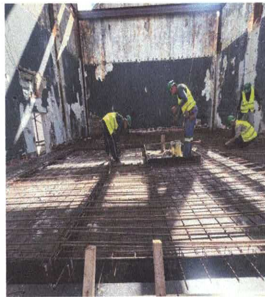
FOTO 12: ARMAÇÃO DE LAJE DE ESTRUTURA CONVENCIONAL DE CONCRETO ARMADO UTILIZANDO AÇO CA-50 DE 8,0 MM.
