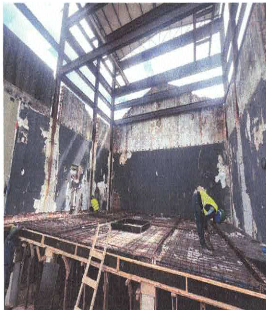
FOTO 10: FABRICAÇÃO DE FÔRMA PARA LAJES, EM CHAPA DE MADEIRA COMPENSADA RESINADA, E = 17 MM.
