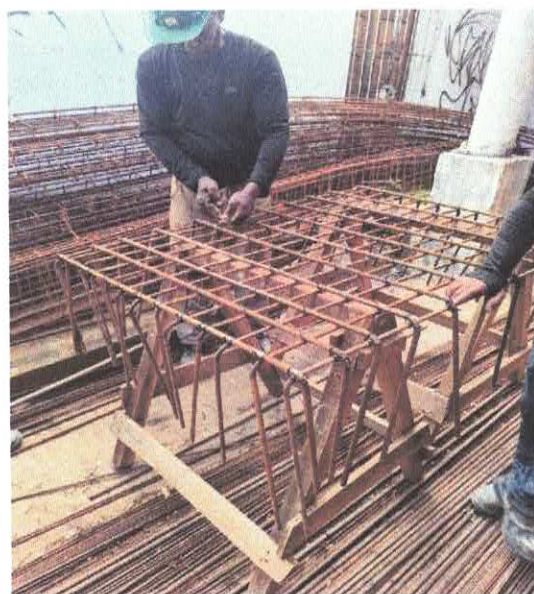
FOTO 07: ARMAÇÃO DE BLOCO, VIGA BALDRAME OU SAPATA UTILIZANDO AÇO CA-50 DE 12,5 MM.
