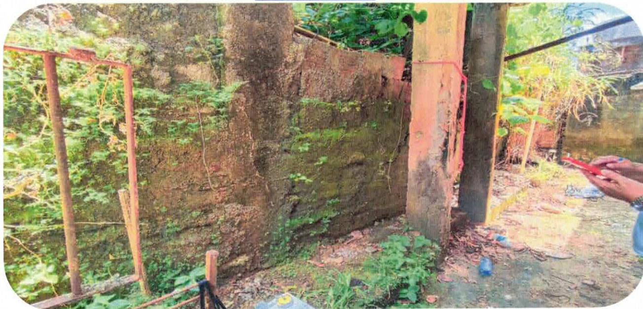
1.2.1 LIMPEZA MANUAL DE VEGETAÇÃO EM TERRENO COM ENXADA.AF_05/2018(FOTO ANTES DA LIMPEZA CASA Nº 86).
