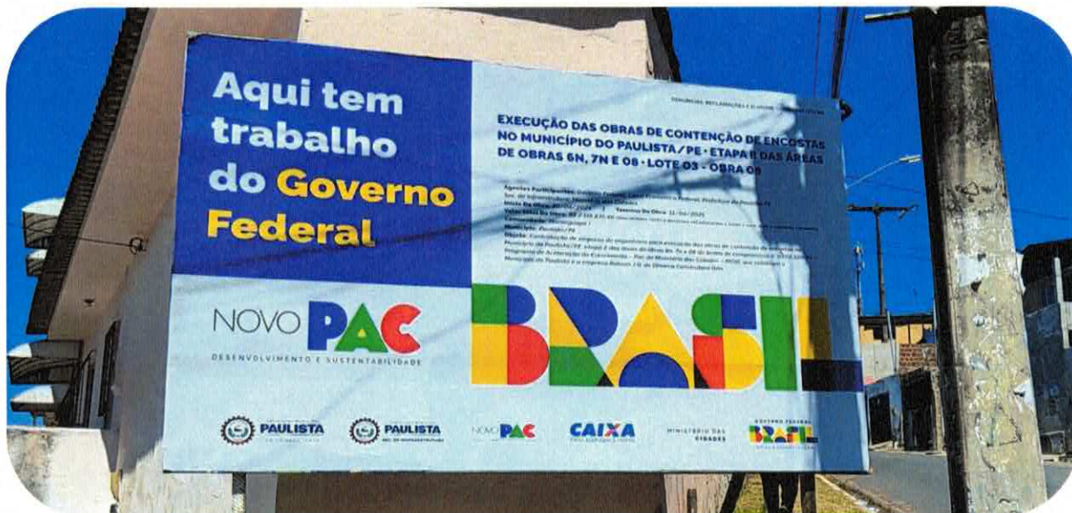
1.1.1. PLACA DE OBRA EM CHAPA DE AÇO GALVANIZADA - FORNECIMENTO E INSTALAÇÃO.
