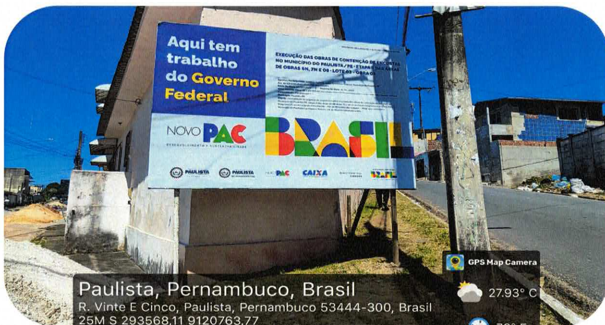
1.1.1. PLACA DE OBRA EM CHAPA DE AÇO GALVANIZADA - FORNECIMENTO E INSTALAÇÃO.
