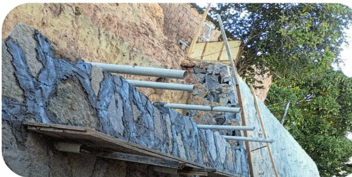
1.2.14. TUBO PVC, SERIE NORMAL, ESGOTO PREDIAL, DN 75 MM, FORNECIDO E INSTALADO EM PRUMADA DE ESGOTO SANITÁRIO OU VENTILAÇÃO. AF_08/2022. (CASA Nº86)
