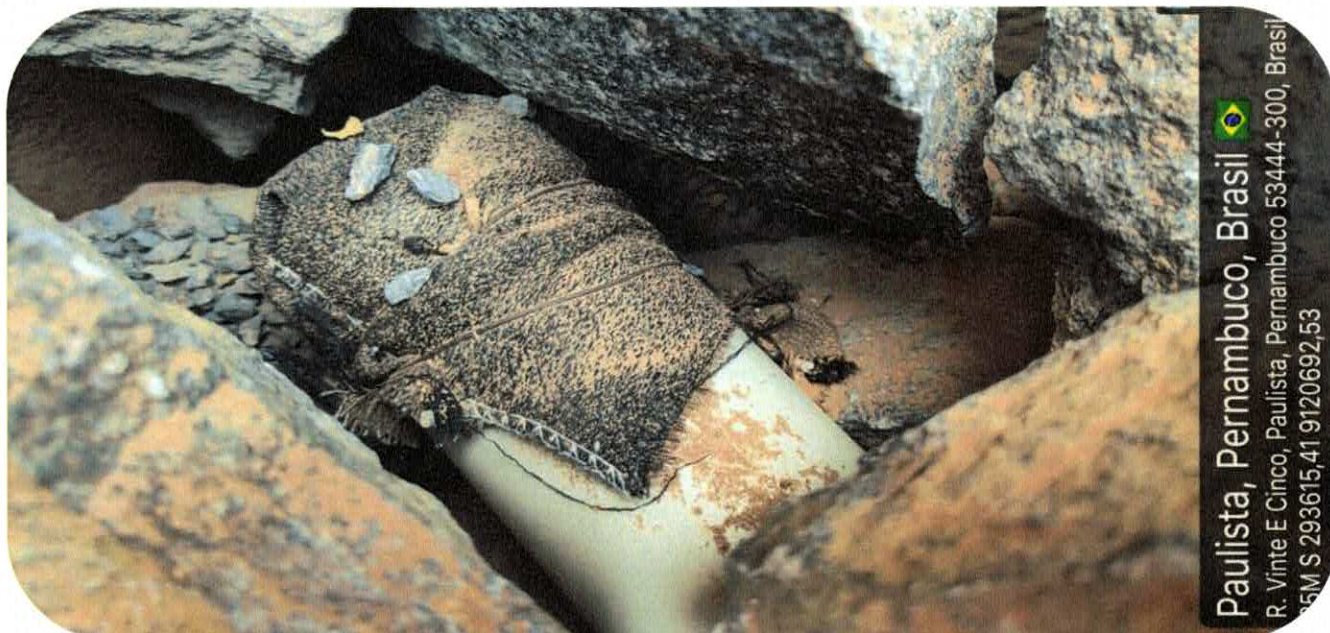
1.2.13. FORNECIMENTO/INSTALAÇÃO DE MANTA BIDIM RT-31 (CASA 86).
