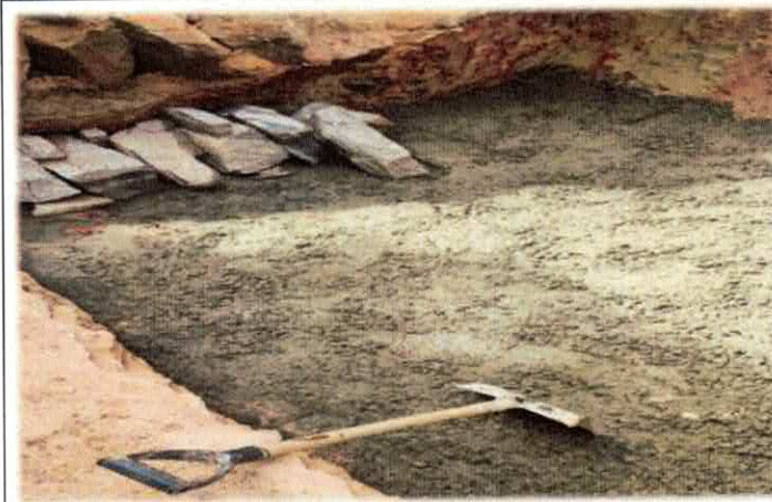
Foto n17 1.2.10. - CONCRETO NÃO ESTRUTURAL, CONSUMO 210KG/M3, PREPARO COM BETONEIRA, INCLUSIVE LANÇAMENTO
