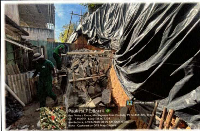
Foto n13 1.2.11. - ALVENARIA EM PEDRA RACHÃO OU PEDRA DE MÃO, ASSENTADA COM ARGAMASSA TRACO 1:6
