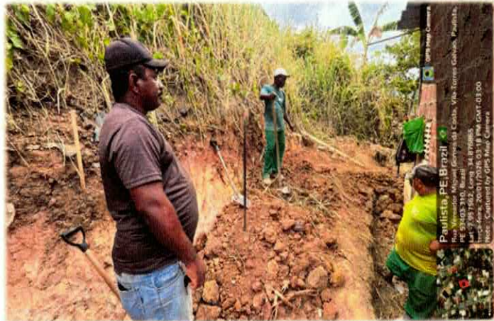
Foto n02 6.1.2. - ESCAVAÇÃO MANUAL DE VALA COM PROFUNDIDADE MENOR OU IGUAL A 1,30 M. AF_02/2021
