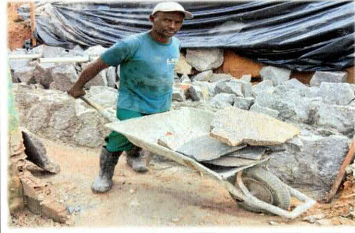
Foto n06 6.2.1. - TRANSPORTE HORIZONTAL DE MATERIAIS DIVERSOS A 30M
