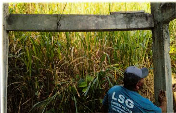
Foto n01 6.1.1. - LIMPEZA MANUAL DE VEGETAÇÃO EM TERRENO COM ENXADA. AF_05/2018
