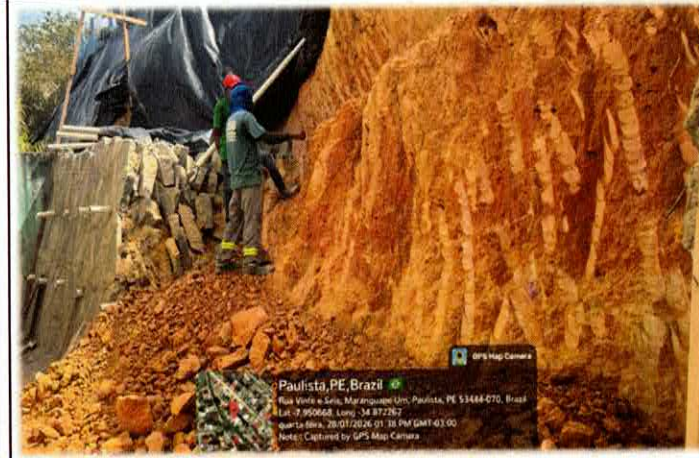
Foto nº12 1.2.2. - ESCAVAÇÃO MANUAL DE VALA COM PROFUNDIDADE MENOR OU IGUAL A 1,30 M
