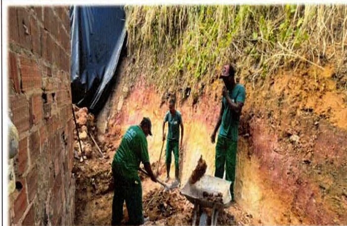
Foto n05 6.1.7. - CARGA MANUAL DE MATERIAL DE 1ª CATEGORIA
