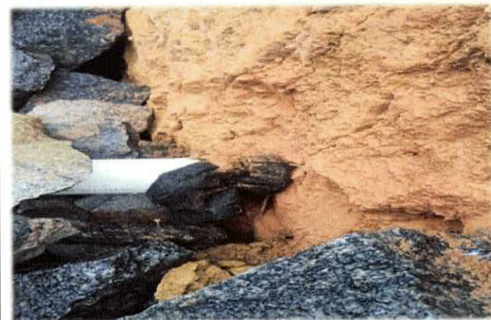
Foto n14 1.2.13. - FORNECIMENTO/INSTALAÇÃO DE MANTA BIDIM RT-31
