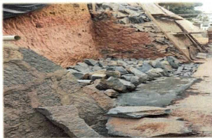
Foto n12 1.2.11. - ALVENARIA EM PEDRA RACHÃO OU PEDRA DE MÃO, ASSENTADA COM ARGAMASSA TRACO 1:6
