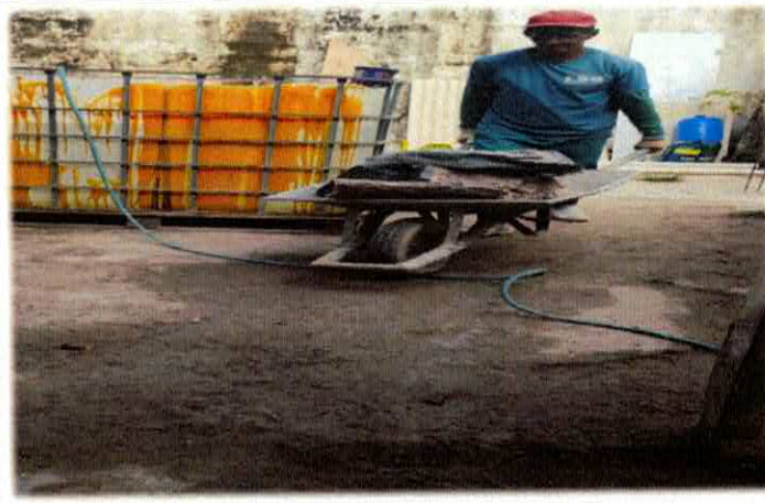
Foto n16 1.2.9. - TRANSPORTE HORIZONTAL DE MATERIAIS DIVERSOS A 30M
