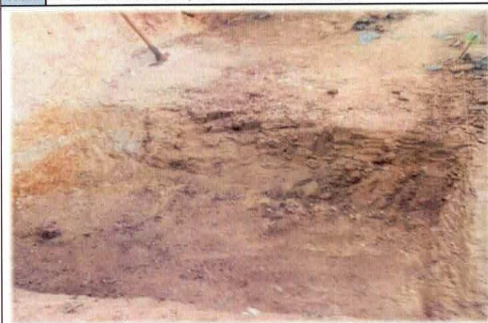
Foto n03 6.1.3. - REGULARIZAÇÃO E COMPACTAÇÃO DE TERRENO, COM SOQUETE
