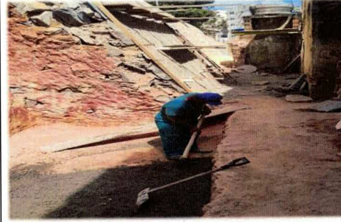
Foto n18 1.2.10. - CONCRETO NÃO ESTRUTURAL, CONSUMO 210KG/M3, PREPARO COM BETONEIRA, INCLUSIVE LANÇAMENTO
