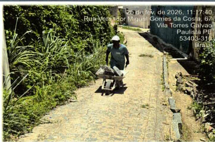
Foto nº02 6.2.1. - TRANSPORTE HORIZONTAL DE MATERIAIS DIVERSOS A 30M.
