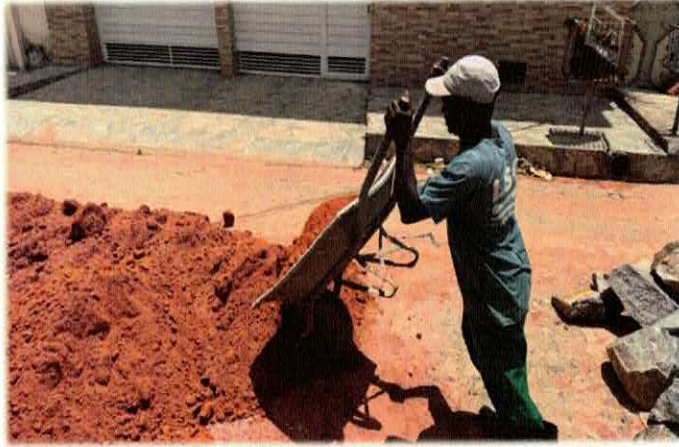
Foto n24 1.2.7. - CARGA MANUAL DE MATERIAL DE 1ª CATEGORIA (BASEADA NA COMPOSIÇÃO 2509/ORSE)
