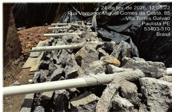
Foto nº11 6.2.6. - TUBO PVC, SÉRIE NORMAL, ESGOTO PREDIAL, DN 75 MM
