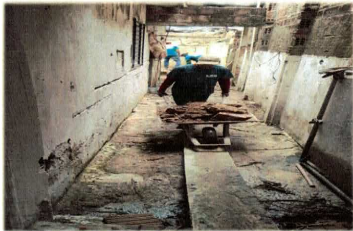
Foto n19 1.2.4. - DEMOLIÇÃO DE ALVENARIA DE BLOCO FURADO, DE FORMA MANUAL, SEM REAPROVEITAMENTO. AF_12/2017
