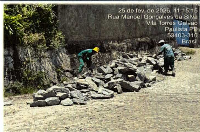
Foto nº01 6.2.1. - TRANSPORTE HORIZONTAL DE MATERIAIS DIVERSOS A 30M.
