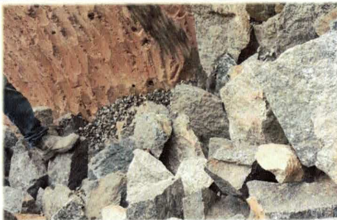
Foto n29 1.2.12. - FORNECIMENTO E ASSENTAMENTO DE BRITA 2 - DRENOS E FILTROS MM
