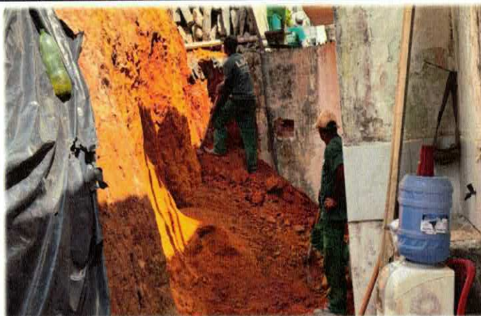
Foto n17 1.2.2. - ESCAVAÇÃO MANUAL DE VALA COM PROFUNDIDADE MENOR OU IGUAL A 1,30 M. AF_02/2021
