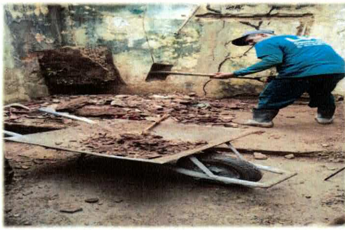
Foto n20 1.2.4. - DEMOLIÇÃO DE ALVENARIA DE BLOCO FURADO, DE FORMA MANUAL, SEM REAPROVEITAMENTO. AF_12/2017
