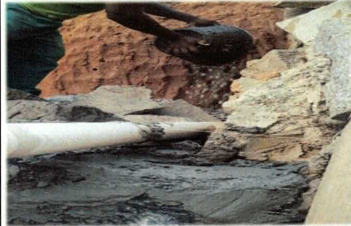
Foto n30 1.2.12. - FORNECIMENTO E ASSENTAMENTO DE BRITA 2 - DRENOS E FILTROS MM
