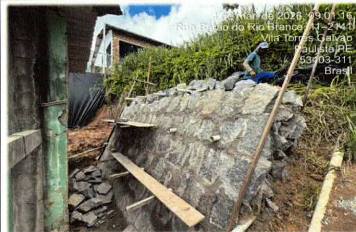
Foto nº05 6.2.3. - ALVENARIA EM PEDRA RACHAO OU PEDRA DE MAO, ASSENTADA COM ARGAMASSA TRACO 1:6
