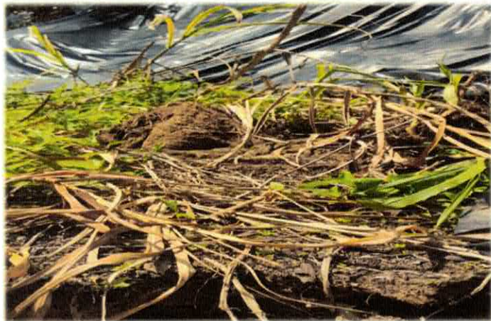
Foto n13 1.2.1. - LIMPEZA MANUAL DE VEGETAÇÃO EM TERRENO COM ENXADA.AF_05/2018
