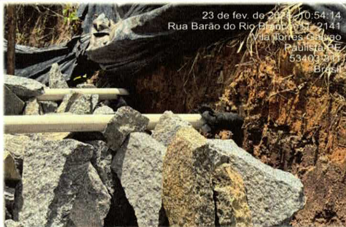
Foto nº09 6.2.5. - FORNECIMENTO/INSTALAÇÃO DE MANTA BIDIM RT-31
