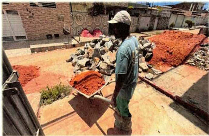
Foto n21 1.2.6. - TRANSPORTE HORIZONTAL DE MATERIAIS DIVERSOS A 30M (BASEADA NA COMPOSIÇÃO 74023/001 SINAPI JULHO/2015)
