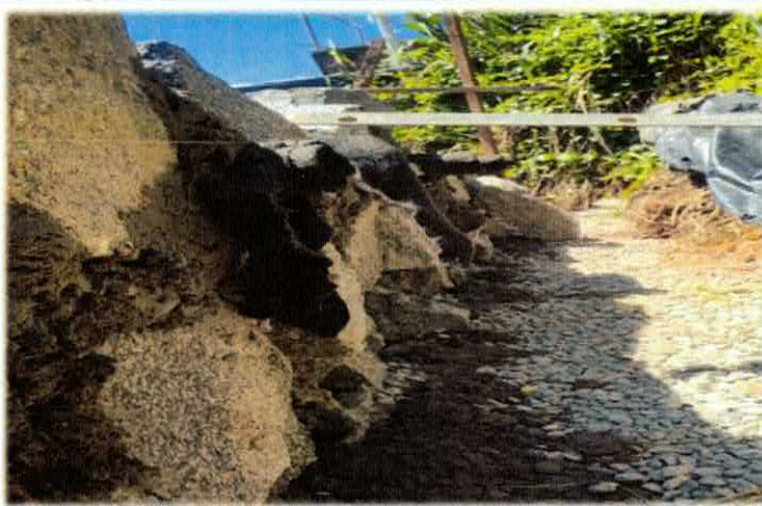
Foto nº08 6.2.4. - FORNECIMENTO E ASSENTAMENTO DE BRITA 2 - DRENOS E FILTROS MM
