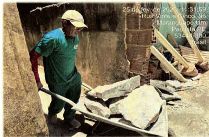
Foto n25 1.2.9. - TRANSPORTE HORIZONTAL DE MATERIAIS DIVERSOS A 30M
