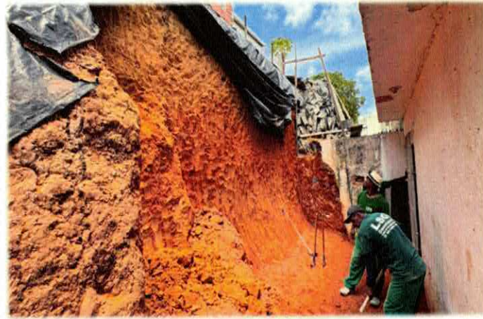
Foto n18 1.2.2. - ESCAVAÇÃO MANUAL DE VALA COM PROFUNDIDADE MENOR OU IGUAL A 1,30 M. AF_02/2021
