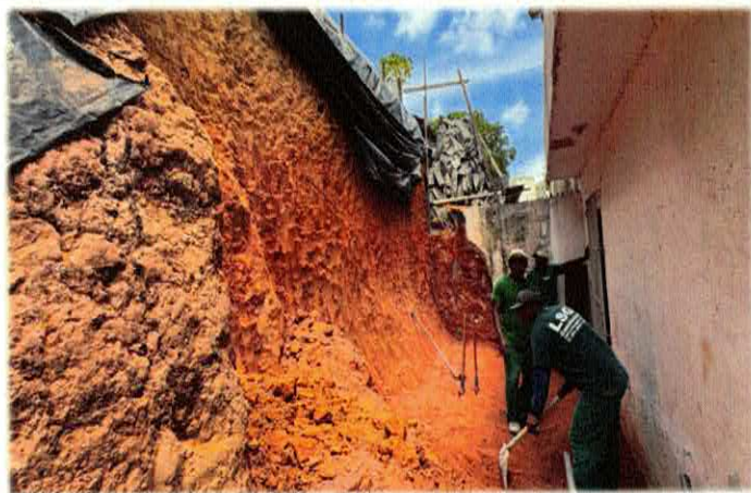
Foto n15 1.2.2. - ESCAVAÇÃO MANUAL DE VALA COM PROFUNDIDADE MENOR OU IGUAL A 1,30 M. AF_02/2021
