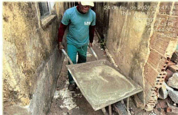
Foto n26 1.2.9. - TRANSPORTE HORIZONTAL DE MATERIAIS DIVERSOS A 30M
