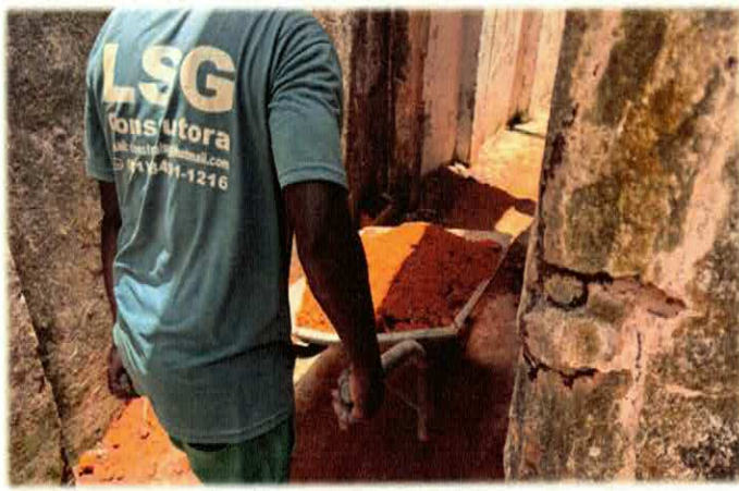
Foto n22 1.2.6. - TRANSPORTE HORIZONTAL DE MATERIAIS DIVERSOS A 30M (BASEADA NA COMPOSIÇÃO 74023/001 SINAPI JULHO/2015)
