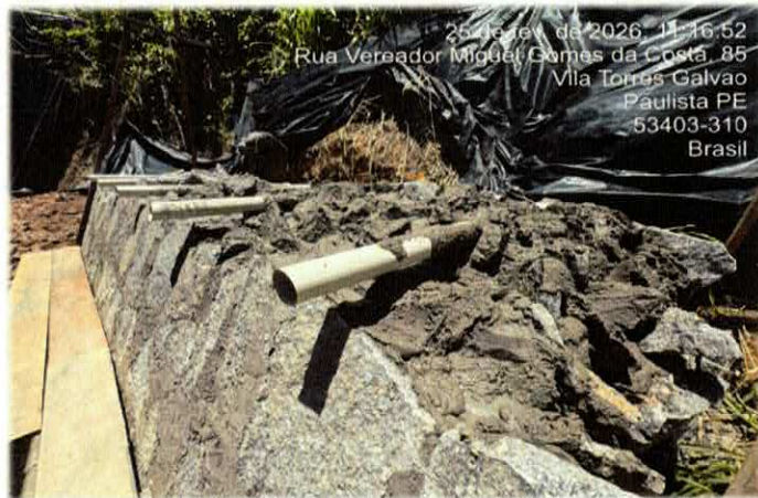
Foto nº12 6.2.6. - TUBO PVC, SÉRIE NORMAL, ESGOTO PREDIAL, DN 75 MM
