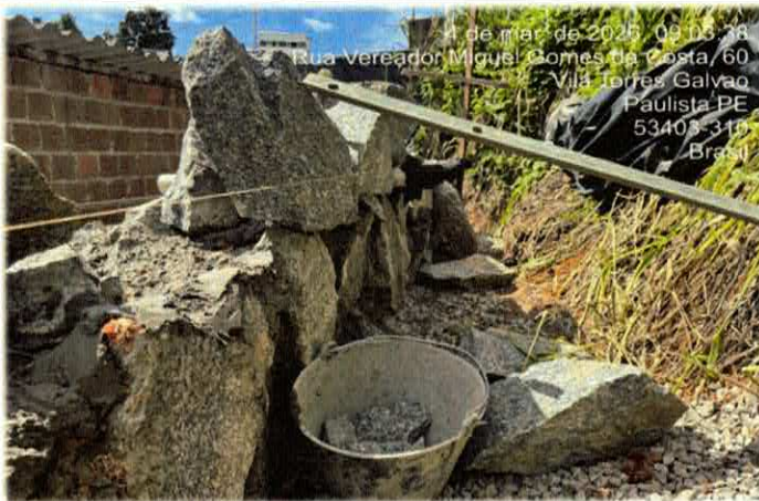
Foto nº10 6.2.5. - FORNECIMENTO/INSTALAÇÃO DE MANTA BIDIM RT-31
