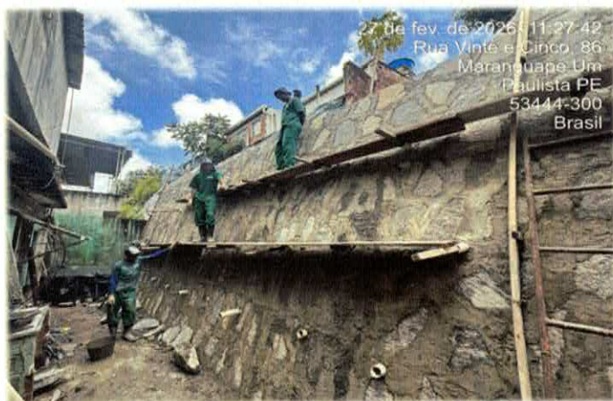
Foto n27 1.2.11. - ALVENARIA EM PEDRA RACHAO OU PEDRA DE MAO, ASSENTADA COM ARGAMASSA TRACO 1:6
