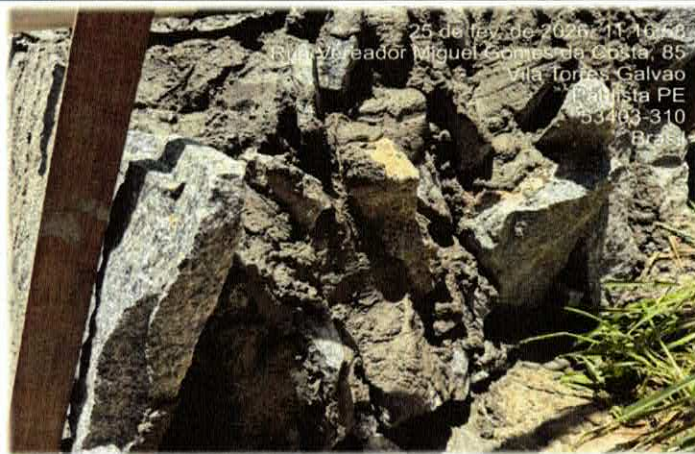
Foto nº04 6.2.3. - ALVENARIA EM PEDRA RACHAO OU PEDRA DE MAO, ASSENTADA COM ARGAMASSA TRACO 1:6
