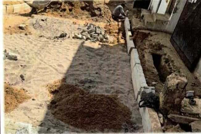
Foto n. 04 ASSENTAMENTO DE GUIA (MEIO-FIO)
