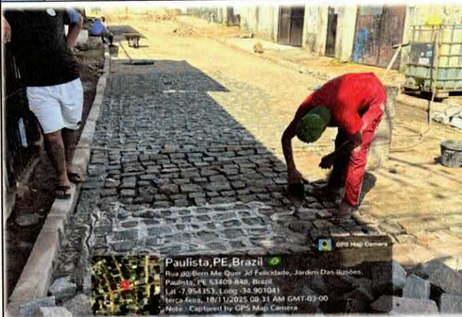
Foto n. 06 LINHA D'ÁGUA COM PARALELEPÍPEDOS
