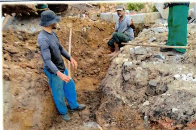
Foto n. 01 REBAIXAMENTO DE PENA D'ÁGUA
