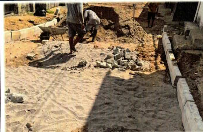
Foto n. 03 ASSENTAMENTO DE GUIA (MEIO-FIO)
