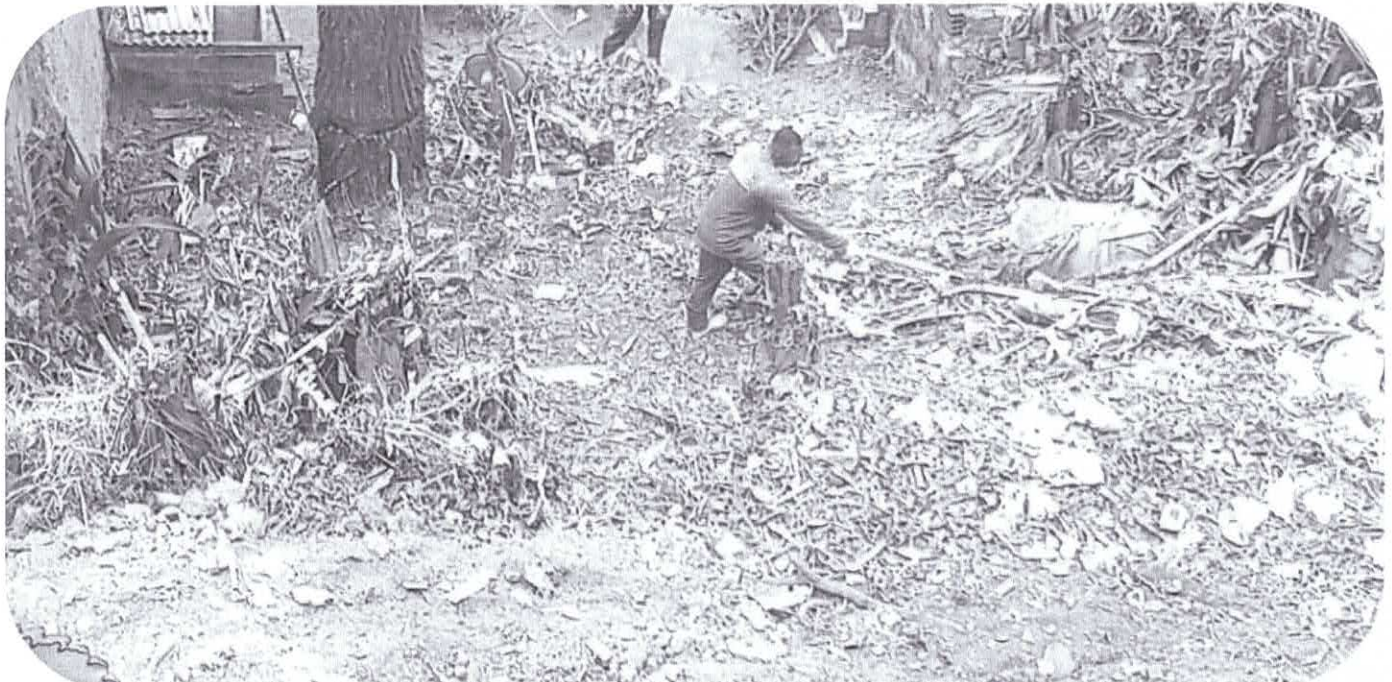
1.1.6. LIMPEZA MANUAL DE VEGETAÇÃO EM TERRENO COM ENXADA.
