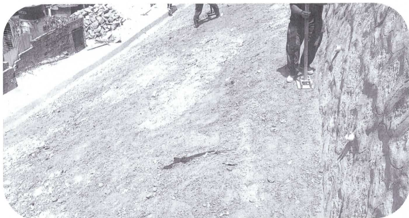
1.2.2 - REGULARIZAÇÃO E COMPACTAÇÃO DE TERRENO, COM SOQUETE.
