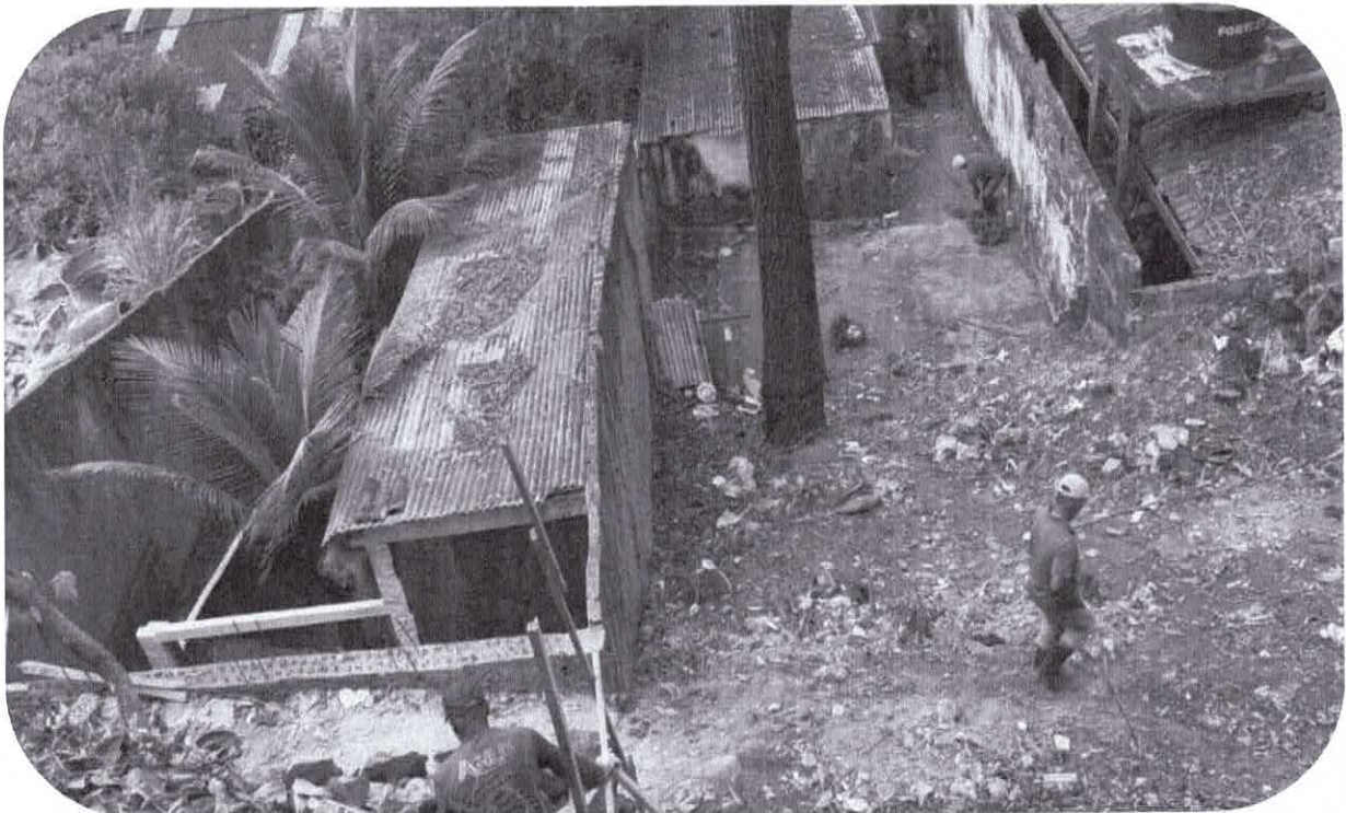
1.1.6. LIMPEZA MANUAL DE VEGETAÇÃO EM TERRENO COM ENXADA.
