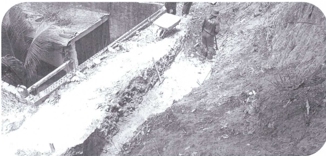
1.2.3 ESCAVAÇÃO MANUAL DE VALA COM PROFUNDIDADE MENOR OU IGUAL A 1,30 M.
