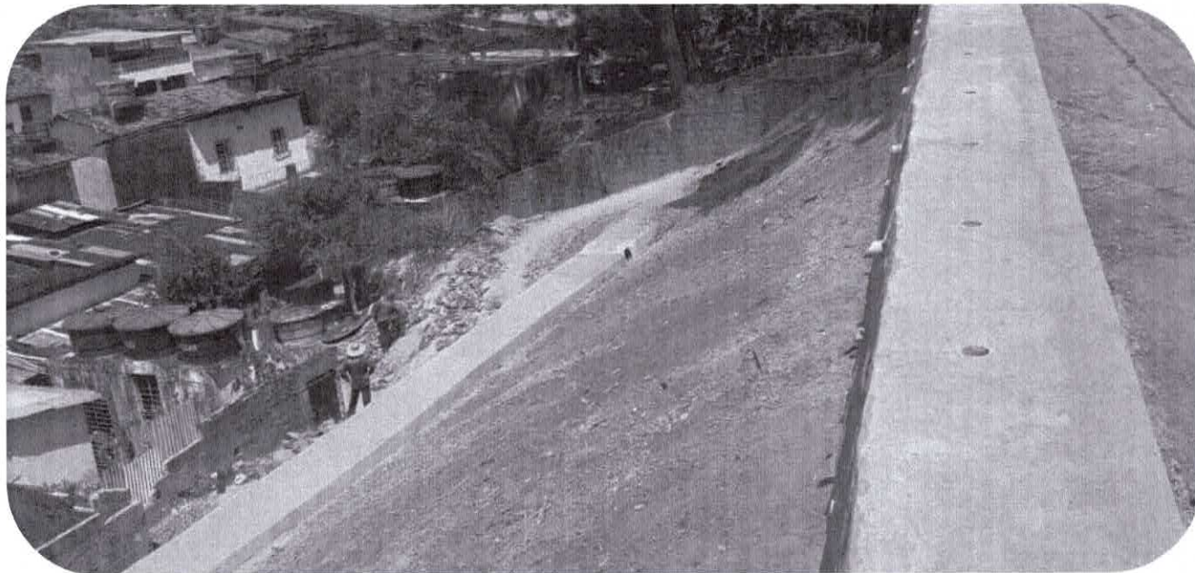
1.2.11 - ALVENARIA EM PEDRA RACHAO OU PEDRA DE MAO, ASSENTADA COM ARGAMASSA TRACO 1:6
