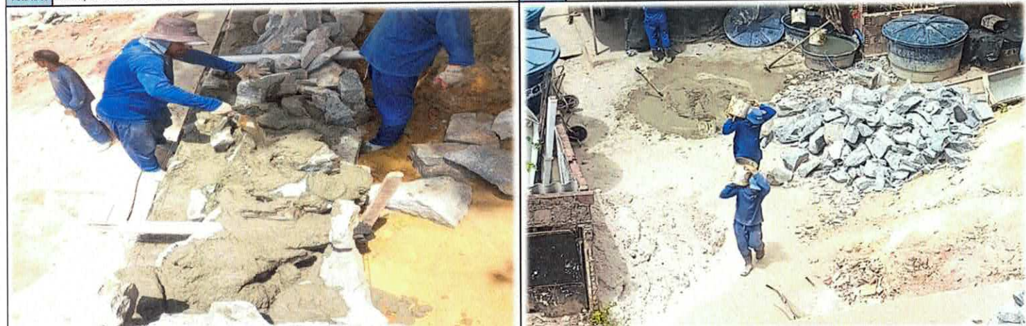
Foto n. 05 EXECUÇÃO DE MURO DE CONTENÇÃO EM ALVENARIA DE PEDRA RACHÃO, COM TRAÇO DE ARGAMASSA, COM COLOCAÇÃO DE BARBACÁ NO MURO DE CONTENÇÃO. Foto n. 06 EXECUÇÃO DO TRAÇO DE ARGAMASSA PARA CONFEÇÃO DO MURO DE CONTENÇÃO.
