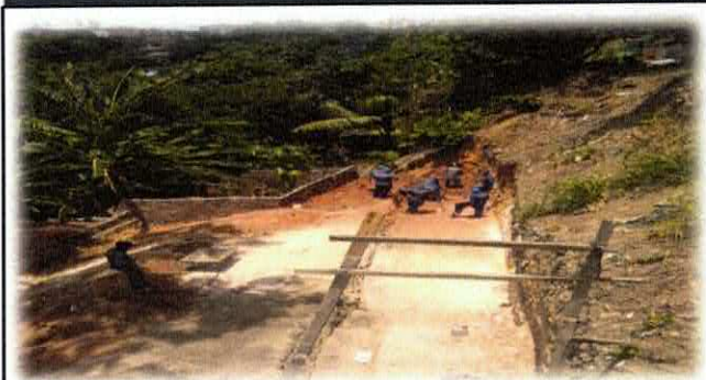
FOTO 01 Edvaldo Soares do Nascimento Engenheiro Civil CREA 1822454069 PE
