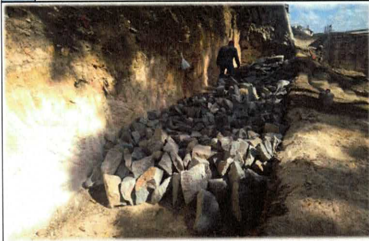
Foto n. 03 EXECUÇÃO DA BASE DE MURO DE CONTENÇÃO EM ALVENARIA DE PEDRA RACHÃO.
