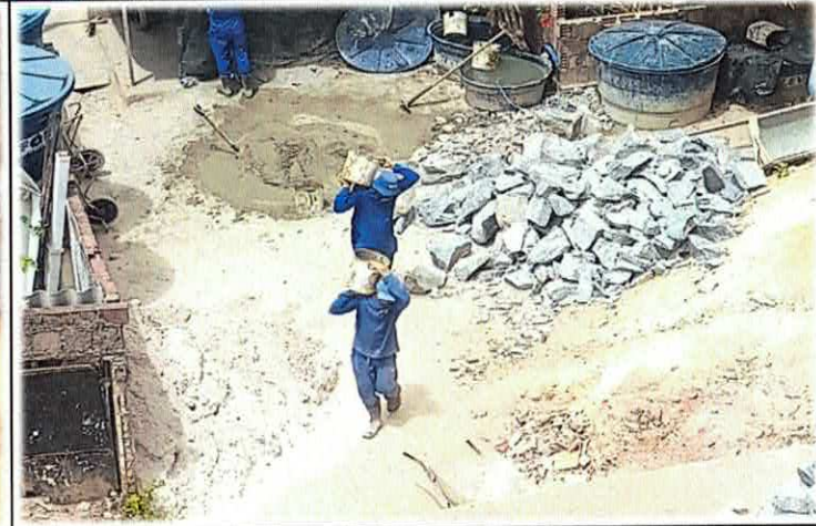
Foto n. 06 EXECUÇÃO DO TRAÇO DE ARGAMASSA PARA CONFECÇÃO DO MURO DE CONTENÇÃO.
