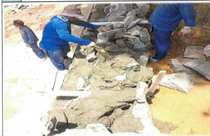
Foto n. 05 EXECUÇÃO DE MURO DE CONTENÇÃO EM ALVENARIA DE PEDRA RACHÃO, COM TRAÇO DE ARGAMASSA, COM COLOCAÇÃO DE BARBACA NO MURO DE CONTENÇÃO.
