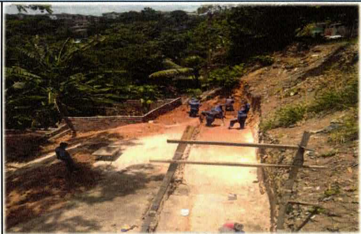
Foto n. 02 ESCAVAÇÃO MANUAL DE VALA COM PROFUNDIDADE MENOR OU IGUAL A 1,30 M. REGULARIZAÇÃO E COMPACTAÇÃO DA VALA.
