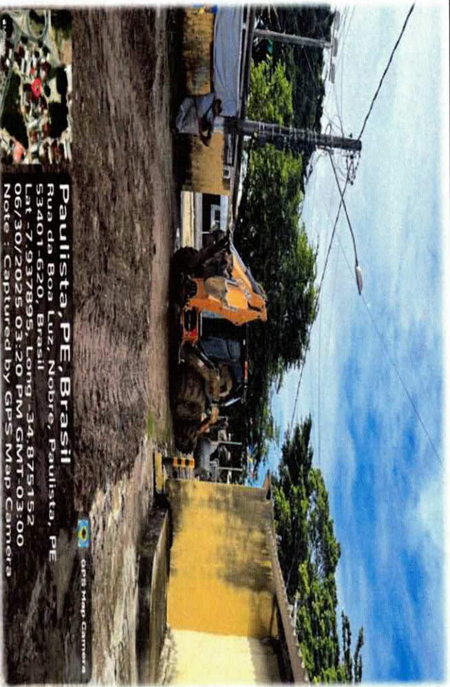
Foto n. 03 ESCAVAÇÃO HORIZONTAL EM SOLO DE 1A CATEGORIA COM RETROESCAVADEIRA.
