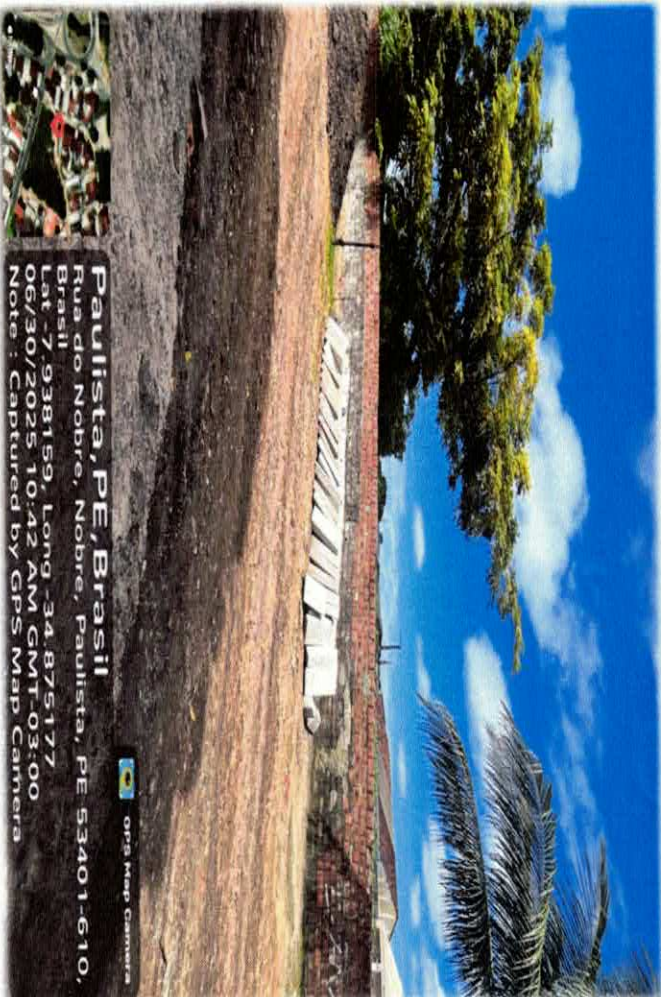
Foto n. 05 MATERIAL DE MEIO-FIO EM CONCRETO PRÉ-FABRICADO, DIMENSÕES 100X15X13X30 CM.
