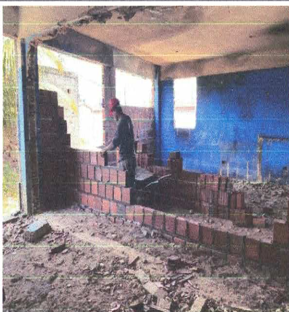
FOTO 07: ALVENARIA EM TIJOLO CERAMICO FURADO, 1 VEZ, ASSENTADO EM ARGAMASSA TRAÇO 1:4 (CIMENTO E AREIA MEDIA NAO PENEIRADA), PREPARO MANUAL, JUNTA 1 CM
