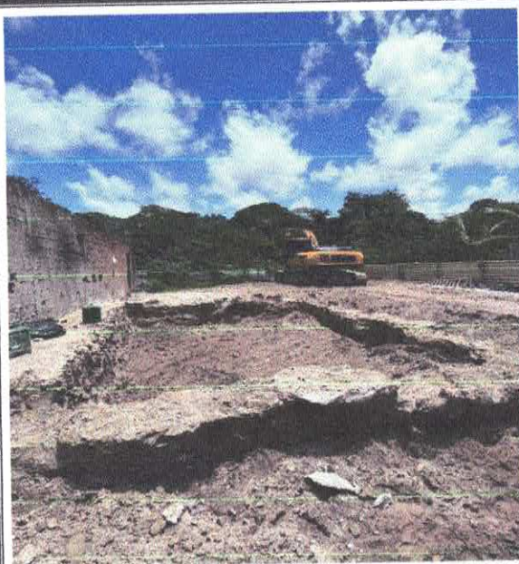
FOTO 03: 2.4.2.1.4. ARRASAMENTO MECANICO DE ESTACA DE CONCRETO ARMADO, DIÂMETROS DE ATÉ 40 CM. AF_05/2021
