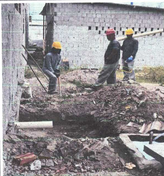
FOTO 11: TUBO PVC, SERIE NORMAL, ESGOTO PREDIAL, DN 50 MM, FORNECIDO E INSTALADO EM RAMAL DE DESCARGA OU RAMAL DE ESGOTO SANITÁRIO. AF_08/2022
