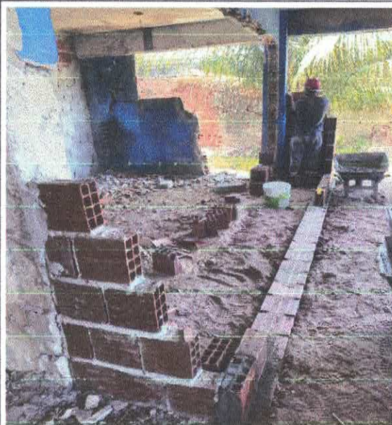
FOTO 06: ALVENARIA EM TIJOLO CERAMICO FURADO, 1/2 VEZ, ASSENTADO EM ARGAMASSA TRAÇO 1:4 (CIMENTO E AREIA MEDIA NAO PENEIRADA), PREPARO MANUAL, JUNTA 1 CM
