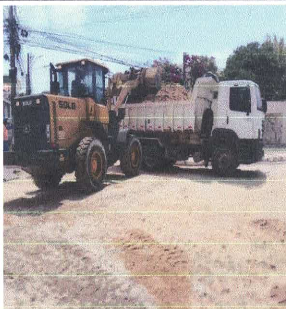
FOTO 19: REMOÇÃO DE MATERIAL DE PRIMEIRA CATEGORIA EM CAMINHÃO BASCULANTE, D.M.T. 12KM, INCLUSIVE CARGA E DESCARGA MECANICAS
