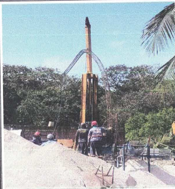
FOTO 02: 2.4.2.1.3. ESTACA RAÍZ, DIÂMETRO DE 40CM, SEM PRESENÇA DE ROCHA (EXCLUSIVE MOBILIZAÇÃO) 100931 SINAP 07/2020
