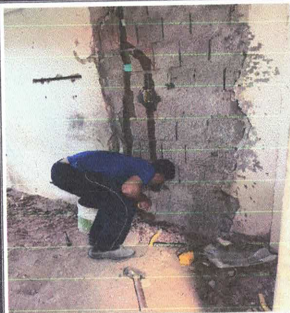
FOTO 04: CHAPISCO APLICADO EM ALVENARIAS E ESTRUTURAS DE CONCRETO INTERNAS, COM COLHER DE PEDREIRO. ARGAMASSA TRAÇO 1:3 COM PREPARO MANUAL. AF_10/2022
