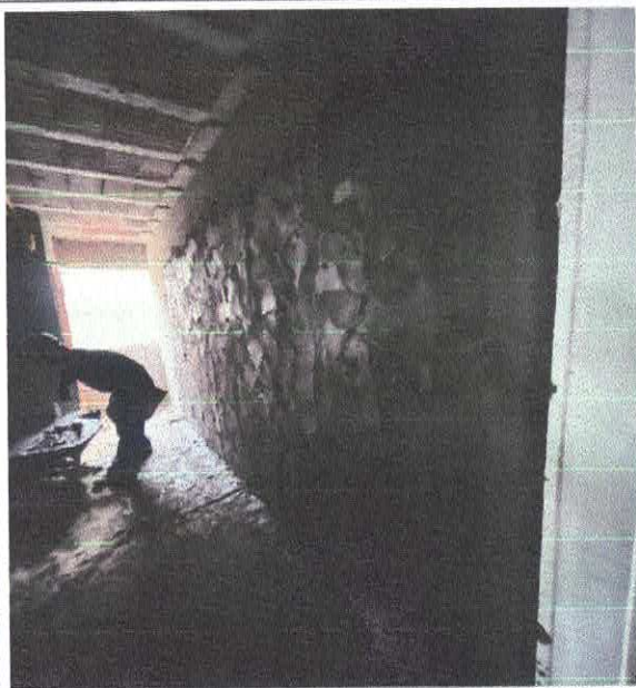
FOTO 09: (COMPOSIÇÃO REPRESENTATIVA) DO SERVIÇO DE EMBOÇO/MASSA ÚNICA, APLICADO MANUALMENTE, TRAÇO 1:2:8, EM BETONEIRA DE 400L
