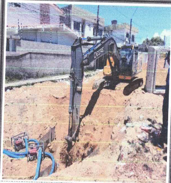
FOTO 16: ESCAVAÇÃO MECANIZADA DE VALA COM PROF. MAIOR QUE 1,5 M ATÉ 3,0 M (MÉDIA MONTANTE E JUSANTE/UMA COMPOSIÇÃO POR TRECHO)
