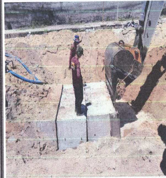
FOTO 24: ASSENTAMENTO DE ADUELAS PREMOLDADAS EM CONCRETO ARMADO SEÇÃO 1,8 X 1,5
