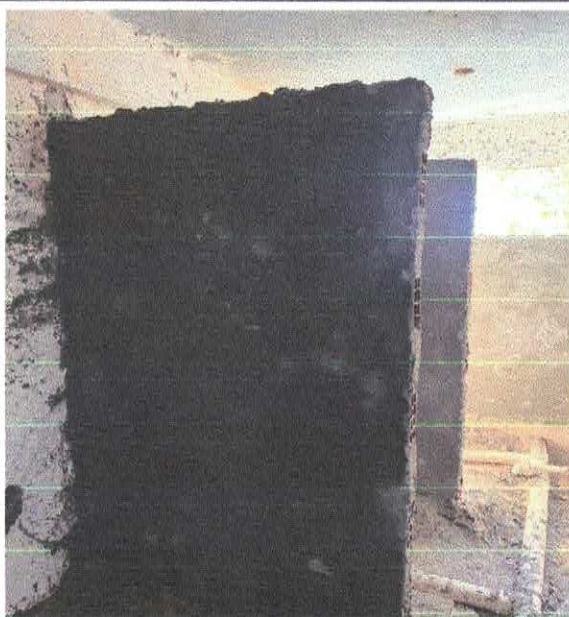
FOTO 05: EMBOÇO, PARA RECEBIMENTO DE CERÂMICA, EM ARGAMASSA TRAÇO 1:2:8, PREPARO MECÂNICO COM BETONEIRA 400L, APLICADO MANUALMENTE
