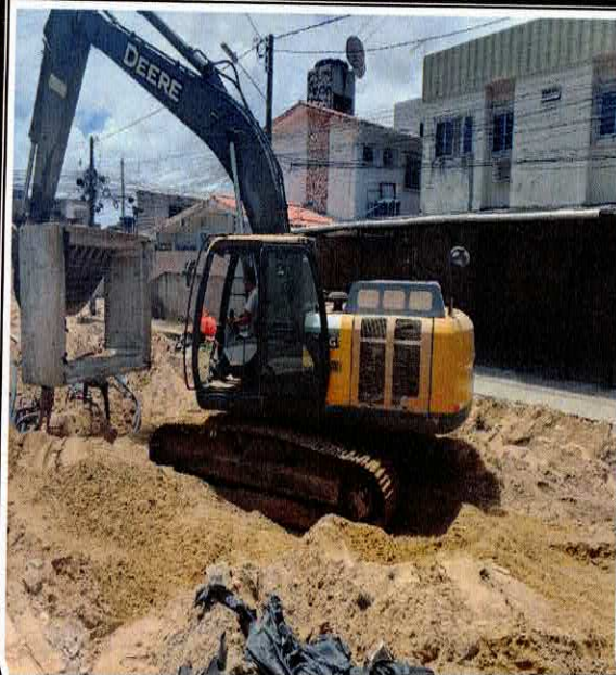
FOTO 08: ASSENTAMENTO DE ADUELAS PREMOLDADAS EM CONCRETO ARMADO SEÇÃO 1,8 X 1,5.
