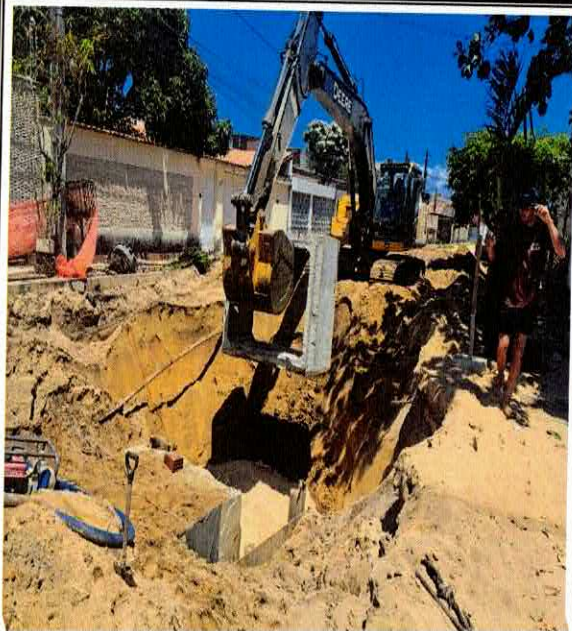
FOTO 07: ASSENTAMENTO DE ADUELAS PREMOLDADAS EM CONCRETO ARMADO SEÇÃO 1,8 X 1,5.
