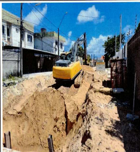
FOTO 03: REATERRO MECANIZADO DE VALA COM ESCAVADEIRA HIDRÁULICA, PROFUNDIDADE DE 1,5 A 3,0 M, COM SOLO DE 1ª CATEGORIA EM LOCAIS COM ALTO NÍVEL DE INTERFERÊNCIA.
