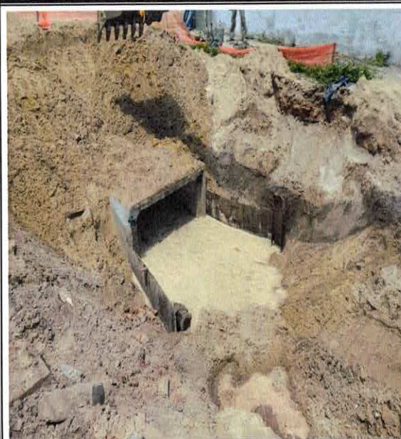
FOTO 27: ESCORAMENTO DE VALAS COM PRANCHOES METALICOS - AREA CRAVADA
