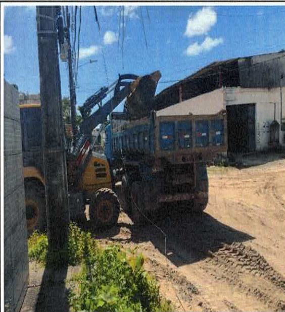
FOTO 02: REMOÇÃO DE ENTULHO EM CAMINHÃO BASCULANTE DMT ATÉ 10KM, INCLUSIVE CARGA MECÂNICA E DESCARGA
