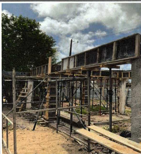
FOTO 17: PILERETES E VIGAS EM ALVENARIAS EM CONCRETO ARMADO PRONTO, FCK 25 MPA CONDIÇÃO A (NBR 12655)...
