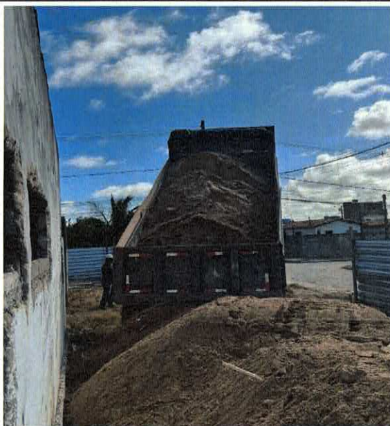
FOTO 13: ATERRO MANUAL DE VALAS COM SOLO ARGILO-ARENOSO E COMPACTAÇÃO MECANIZADA. AF_05/2016
