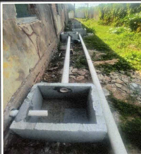
FOTO 19: TUBO PVC, SÉRIE NORMAL, ESGOTO PREDIAL, DN 100 MM, FORNECIDO E INSTALADO EM RAMAL DE DESCARGA OU RAMAL DE ESGOTO SANITÁRIO. AF_08/2022
