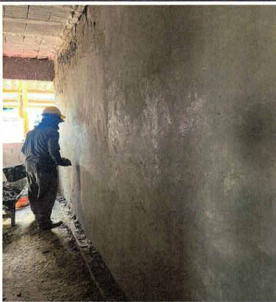
FOTO 15: MASSA ÚNICA, PARA RECEBIMENTO DE PINTURA, EM ARGAMASSA TRAÇO 1:2:8, PREPARO MECÂNICO COM BETONEIRA 400L...
