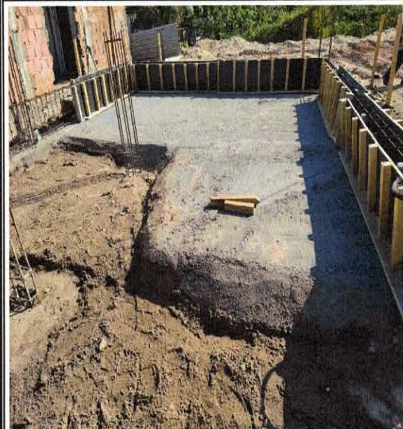
FOTO 08: LASTRO DE CONCRETO MAGRO, APLICADO EM PISOS, LAJES SOBRE SOLO OU RADIERES. AF_08/2017
