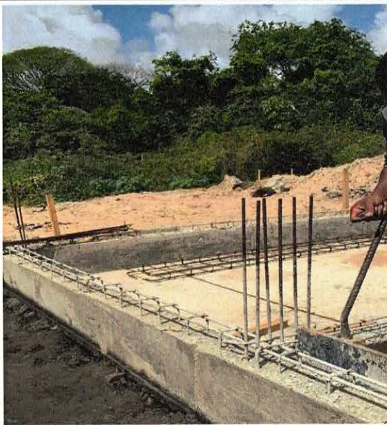
FOTO 09: CONCRETO FCK = 40MPA, TRAÇO 1:1,6:1,9 (EM MASSA SECA DE CIMENTO/ AREIA MÉDIA/ BRITA 1) - PREPARO MECÂNICO COM BETONEIRA 600 L. AF_05/2021
