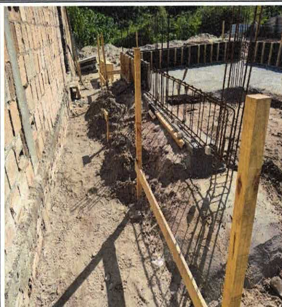
FOTO 03: LOCAÇÃO CONVENCIONAL DE OBRA, UTILIZANDO GABARITO DE TÁBUAS CORRIDAS PONTALEADAS A CADA 2,00M - 2 UTILIZAÇÕES. AF_10/2018
