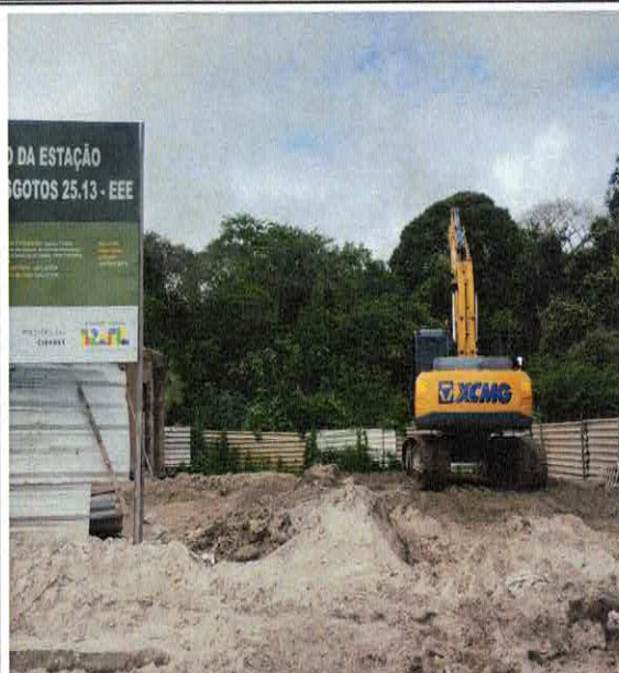
FOTO 07: EXECUCAO DE ATERRO ABRANGENDO ESPALHAMENTO, HOMOGENEIZACAO, UMEDECIMENTO E COMPACTACAO... (MATERIAL PROVENIENTE DAS ADUELAS)
