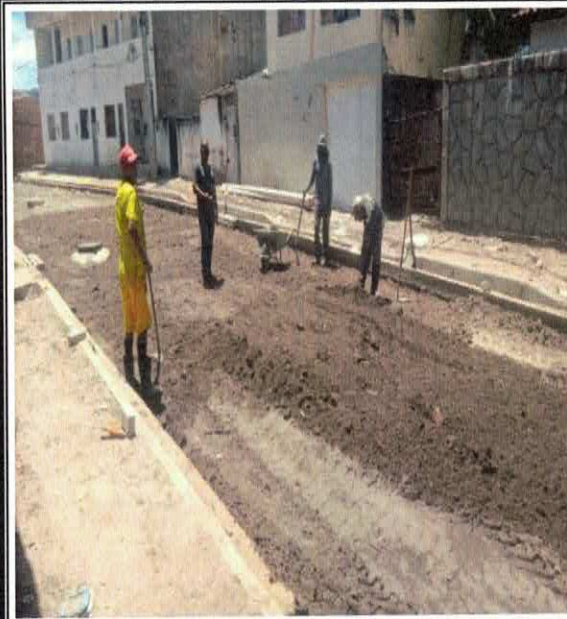
FOTO 20: PAVIMENTAÇÃO DA RUA SÃO PEDRO - REGULARIZAÇÃO E COMPACTAÇÃO DE SUBLEITO - CBR \geq 10\%
