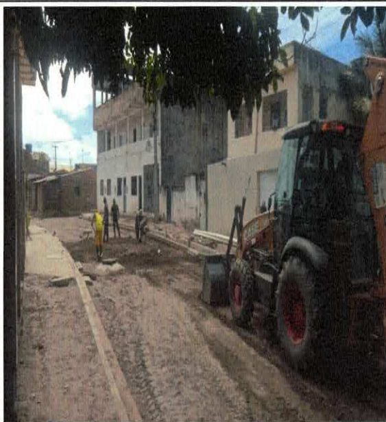
FOTO 21: PAVIMENTAÇÃO DA RUA SÃO PEDRO - EXECUÇÃO DE ATERRO ABRANGENDO ESPALHAMENTO, HOMOGENEIZAÇÃO, UMEDECIMENTO E COMPACTAÇÃO...
