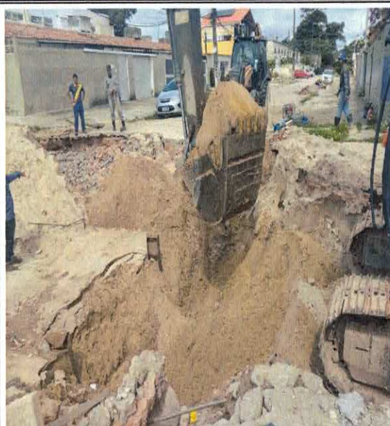
FOTO 23: ESCAVAÇÃO MECANIZADA DE VALA COM PROFUNDIDADE MAIOR QUE 1,5 M ATÉ 3,0 M (MÉDIA MONTANTE E USANTE/UMA COMPOSIÇÃO POR TRECHO), COM ESCAVADEIRA (1,2 M 3 )...
