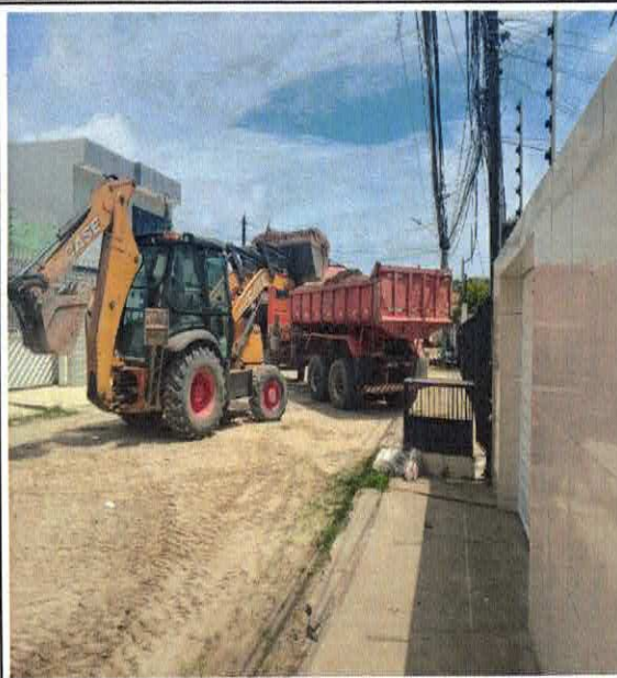
FOTO 26: REMOÇÃO DE MATERIAL DE PRIMEIRA CATEGORIA EM CAMINHÃO BASCULANTE, D.M.T. 12KM, INCLUSIVE CARGA E DESCARGA MECANICAS.
