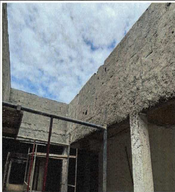
FOTO 14: CHAPISCO APLICADO EM ALVENARIAS E ESTRUTURAS DE CONCRETO INTERNAS, COM COLHER DE PEDREIRO. ARGAMASSA TRAÇO 1:3 COM PREPARO MANUAL. AF_10/2022
