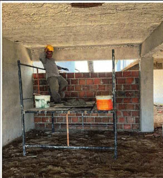
FOTO 16: APLICAÇÃO DE FUNDO SELADOR ACRÍLICO EM PAREDES, UMA DEMÃO. AF_06/2014
