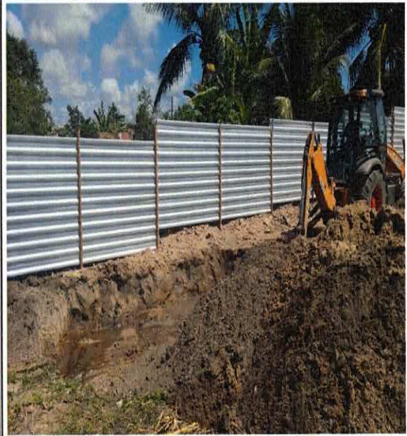
FOTO 06: ATERRO E COMPACTAÇÃO MECANIZADA COM MATERIAL PROVENIENTE DE ESCAVAÇÃO
