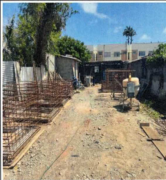
FOTO 30: FORNECIMENTO DE ADUELAS PREMOLDADAS EM CONCRETO ARMADO FCK 25 MPA SEÇÃO 1,8 X 1,5 INCLUSIVE FORMA, ESCORAMENTO E ARMAÇÃO.
