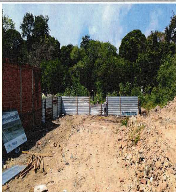
FOTO 01: LIMPEZA MECANIZADA DE CAMADA VEGETAL, VEGETAÇÃO E PEQUENAS ÁRVORES (DIÂMETRO DE TRONCO MENOR QUE 0,20 M), COM TRATOR DE ESTEIRAS. AF_05/2018
