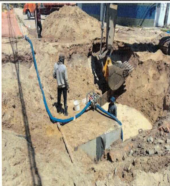
FOTO 29: ESGOTAMENTO COM BOMBA CENTRÍFUGA MONOESTÁGIO COM MOTOR ELÉTRICO O A COMBUSTÃO CHP DIURNO
