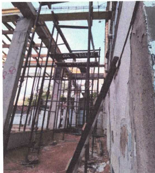
FOTO 16: COMP. 115 - ESCORAMENTO METÁLICO PARA LAJES E VIGAS, C/ ESCORAS TUBULARES TIPO "B" (H=3,30 A 4,50 M), COM MONTAGEM E DESMONTAGEM.
