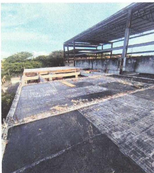
FOTO 13: FABRICAÇÃO DE FÔRMA PARA LAJES, EM CHAPA DE MADEIRA COMPENSADA RESINADA, E = 17 MM.
