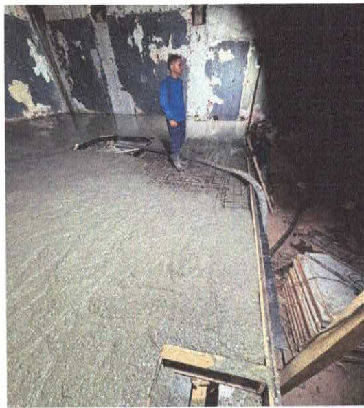
FOTO 14: ARMAÇÃO DE LAJE DE ESTRUTURA CONVENCIONAL DE CONCRETO ARMADO UTILIZANDO AÇO CA-50 DE 6,3 MM.
