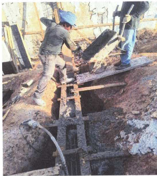
FOTO 08: ESCAVAÇÃO MANUAL DE VALA PARA VIGA BALDRAME (INCLUINDO ESCAVAÇÃO PARA COLOCAÇÃO DE FÔRMAS).
