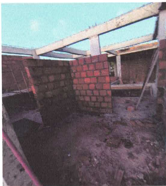
FOTO 19: ALVENARIA DE EMBASAMENTO COM BLOCO ESTRUTURAL DE CERÂMICA, DE 14X19X29CM E ARGAMASSA DE ASSENTAMENTO COM PREPARO EM BETONEIRA.
