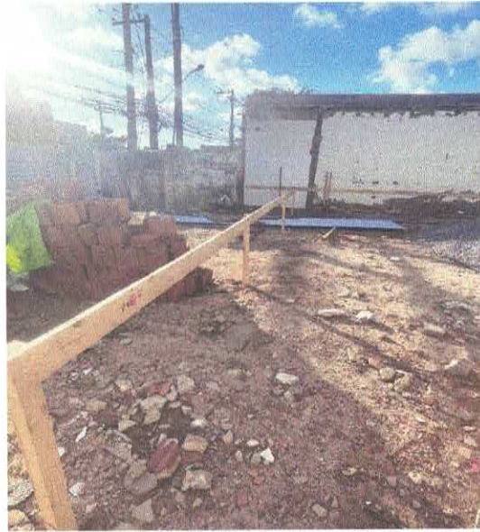
FOTO 18: LOCAÇÃO CONVENCIONAL DE OBRA, UTILIZANDO GABARITO DE TÁBUAS CORRIDAS PONTALEITADAS A CADA 2,00M - 2 UTILIZAÇÕES.
