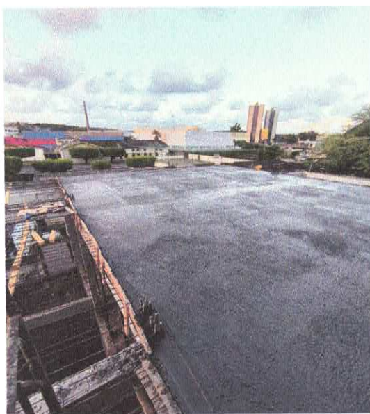
FOTO 15: COMP. 113 - CONCRETO SIMPLES USINADO FCK=35MPa, BOMBEADO, LANÇADO E ADENSADO EM SUPERESTRUTURA.
