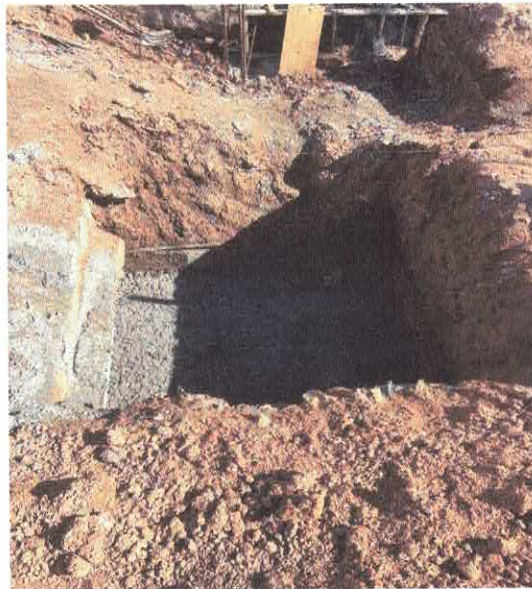
FOTO 10: LASTRO DE CONCRETO MAGRO, APLICADO EM BLOCOS DE COROAMENTO OU SAPATAS, ESPESSURA DE 5 CM.
