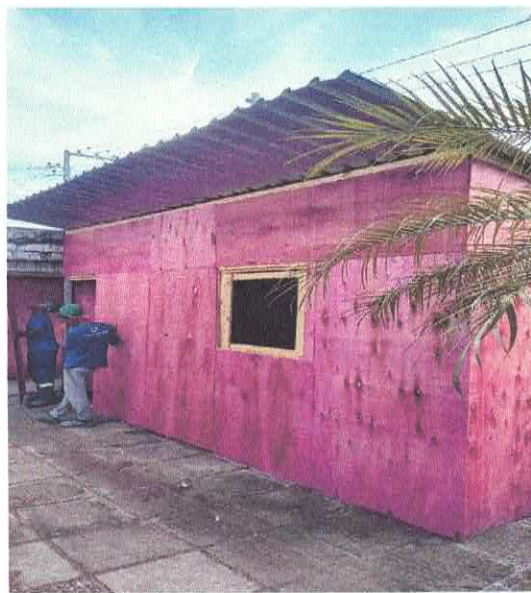
FOTO 02: EXECUÇÃO DE ESCRITÓRIO EM CANTEIRO DE OBRA EM CHAPA DE MADEIRA COMPENSADA, NÃO INCLUSO MOBILIÁRIO E EQUIPAMENTOS.
