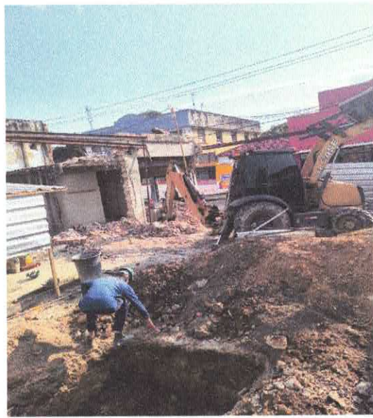
FOTO 04: DEMOLIÇÃO DE PILARES E VIGAS EM CONCRETO ARMADO, DE FORMA MECANIZADA COM MARTELETE, SEM REAPROVEITAMENTO.
