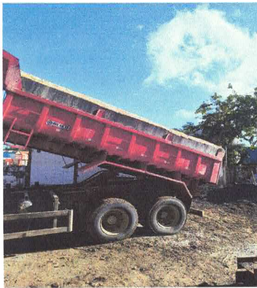
FOTO 06: CARGA, MANOBRA E DESCARGA DE ENTULHO EM CAMINHÃO BASCULANTE 10 M³ - CARGA COM ESCAVADEIRA HIDRÁULICA.
