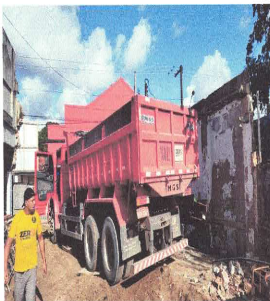
FOTO 07: TRANSPORTE COM CAMINHÃO BASCULANTE DE 10 M³, EM VIA URBANA EM REVESTIMENTO PRIMÁRIO.
