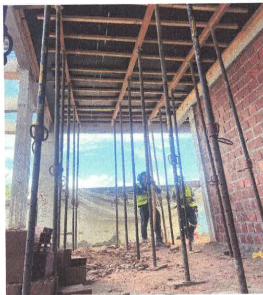
FOTO 12: COMP. 115 - ESCORAMENTO METÁLICO PARA LAJES E VIGAS, C/ ESCORAS TUBULARES TIPO "B" (H=3,30 A 4,50 M), COM MONTAGEM E DESMONTAGEM.
