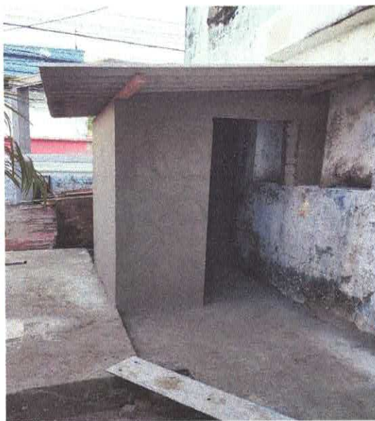
FOTO 03: EXECUÇÃO DE SANITÁRIO E VESTIÁRIO EM CANTEIRO DE OBRA NÃO INCLUSO MOBILIÁRIO.
